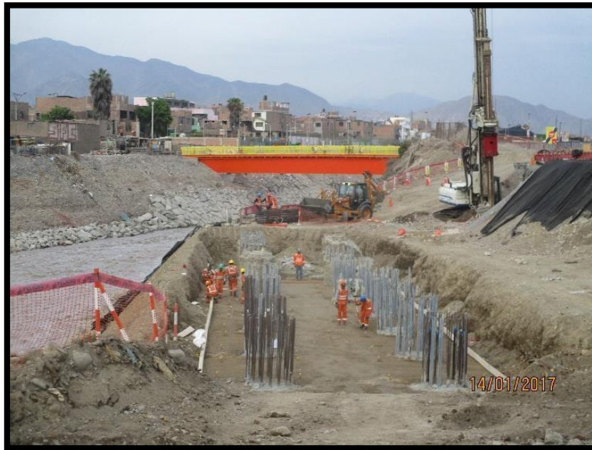
Figura 61 Descabezado de pilotes.
