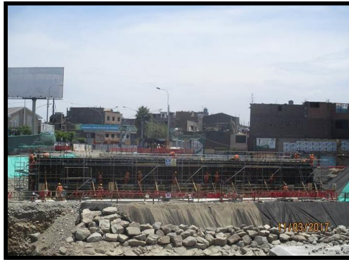
Figura 81 Colocación de encofrado para 2da etapa de pantalla de estribo.
