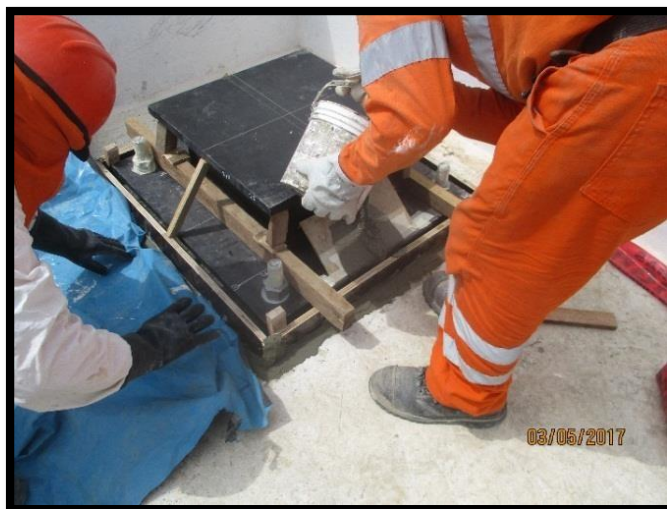
Figura 87 colocación de grouting nivelante.
