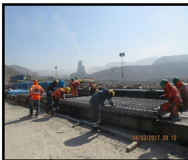
Figura 119 Colocación de encofrado metálico para losas prefabricadas.
