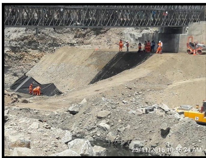
Figura 53 Finalización del relleno estructural y colocación de geotextil.
