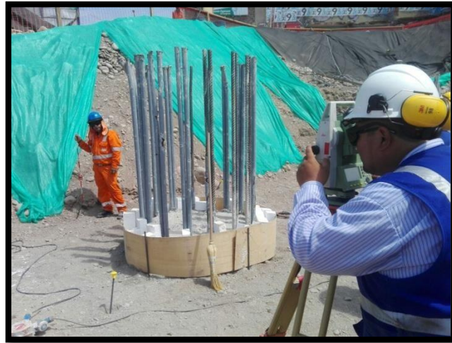
Figura 66 Verificación de niveles para el solado de la zapata.
