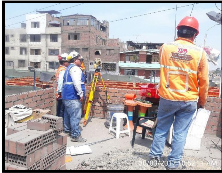
Figura 95 Controles topográficos de las vigas metálica.
