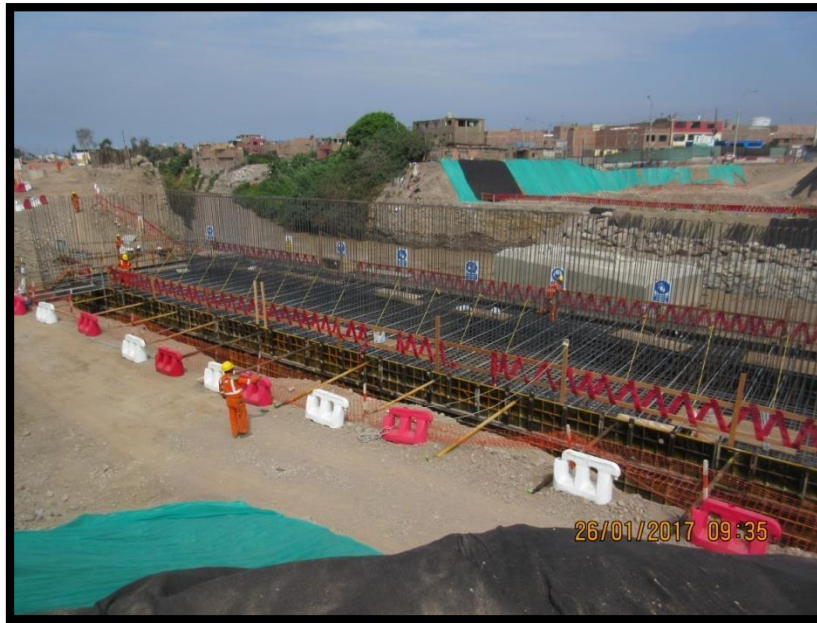
Figura 68 Encofrado final de la zapata.
