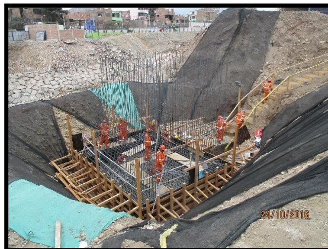
Figura 27 Colocación de acero para la zapata y pantalla de estribo.
