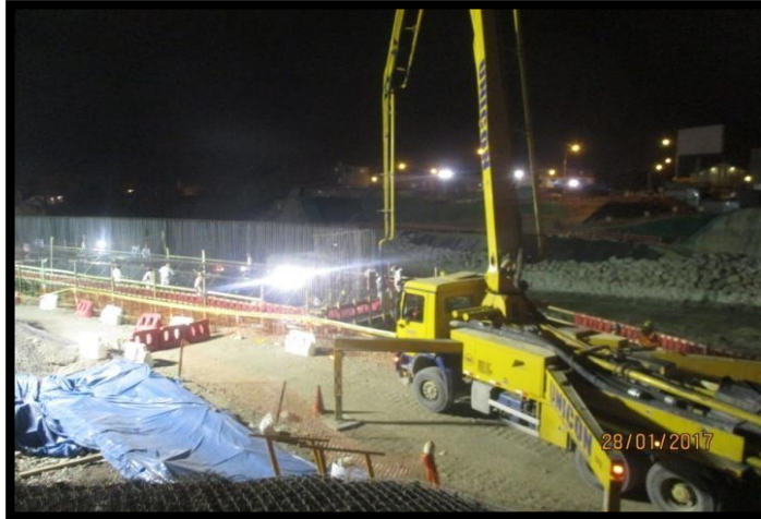
Figura 69 Vaciado de la zapata 1era etapa.
