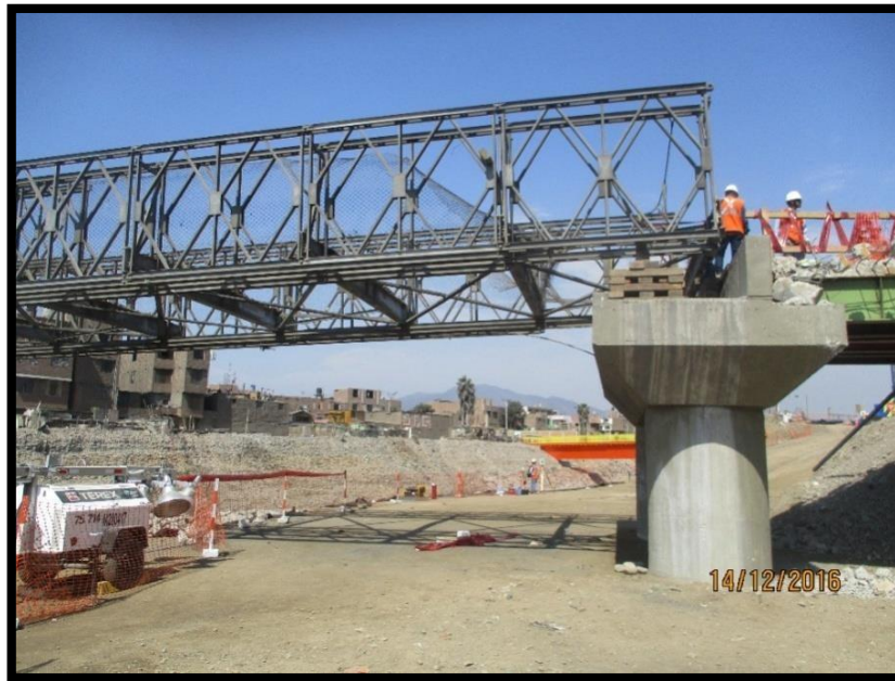
Figura 45 Estructura del Puente Bailey gateado.
