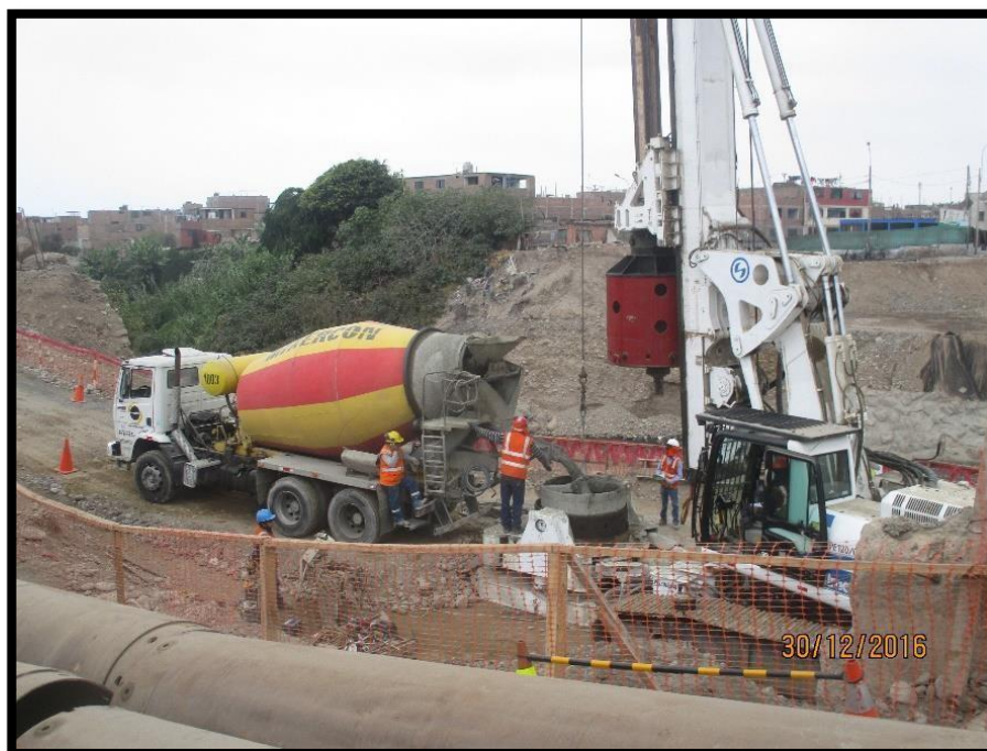
Figura 59 Colocación de la armadura de pilotes.
