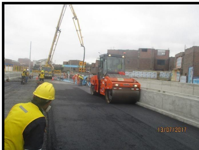
Figura 135 Compactación del asfalto mediante rodillo tándem.
