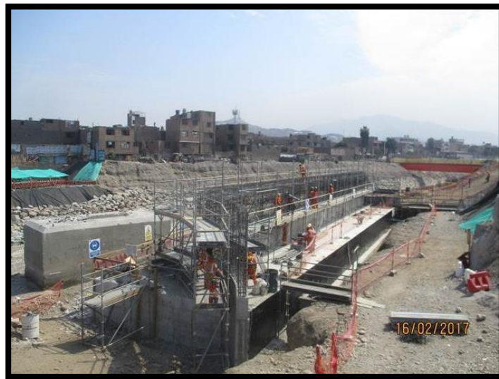
Figura 80 Colocación de acero para 2da etapa de pantalla de estribo.
