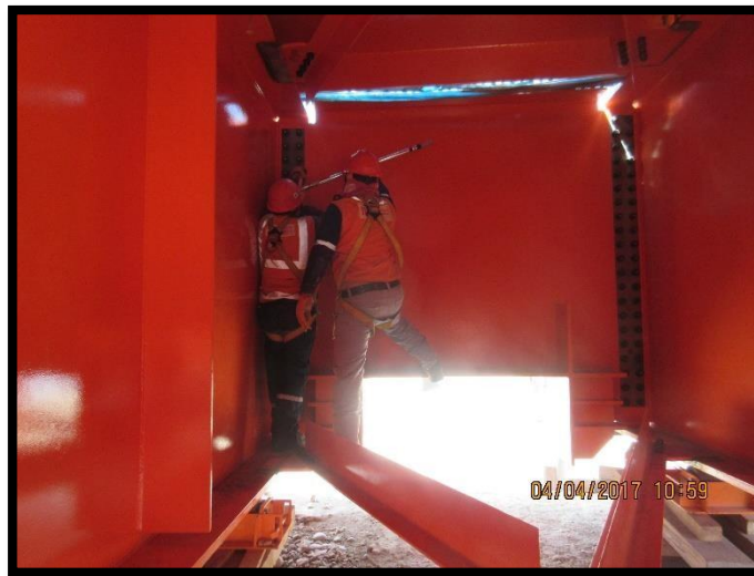
Figura 101 Verificación del Torque.
