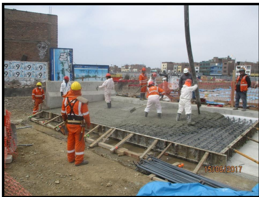
Figura 129 Vaciado de concreto de losa de transición con f'c = 280 \text{ kg/cm}^2 .
