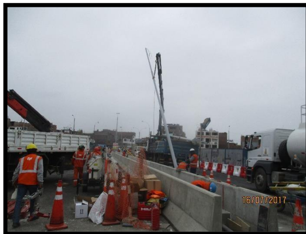
Figura 139 Colocación de alumbrado publico
