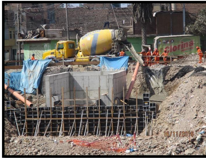
Figura 30 Relleno fluido para alcanzar la cota del nivel terminado.
