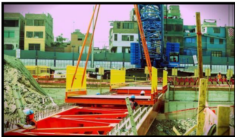
Figura 32 Montaje de tablero peatonal y barandas.
