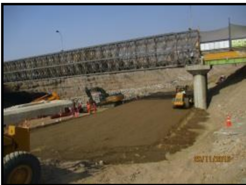
Figura 51 Inicio del relleno estructural Estribo 1.
