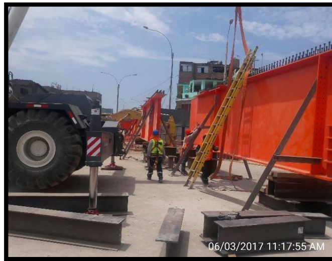
Figura 91 Inicio de los trabajos de ensamblaje de los tramos para las vigas metálicas.
