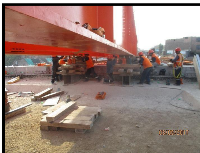
Figura 114 Inicio del lanzamiento vigas sobre vigas metálicas colocadas.
