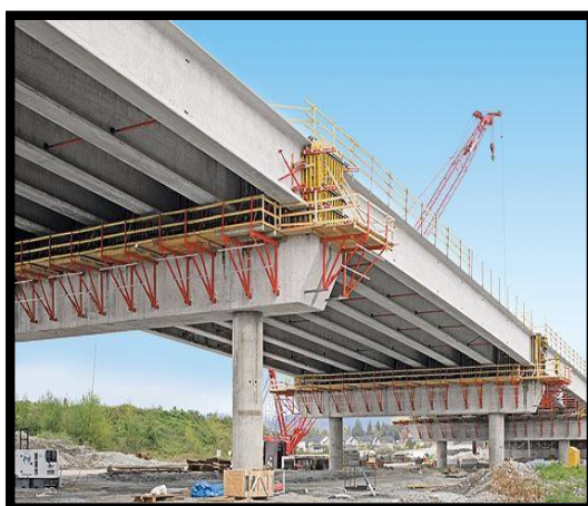
Figura 8 Puente tipo viga
