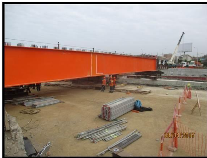
Figura 105 Inicio de lanzamiento del 1er grupo de vigas 11, 12 y 13.
