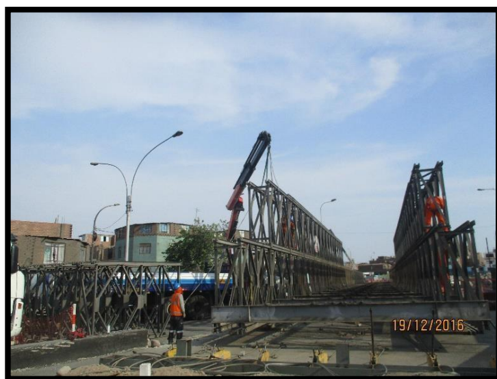
Figura 50 Culminación del desmontaje y despiece final del Puente Bailey.
