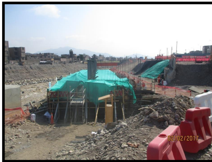
Figura 73 Curado de la zapata.
