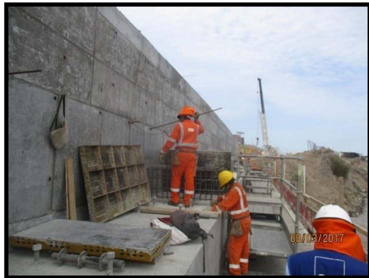
Figura 83 Encofrado para topes
