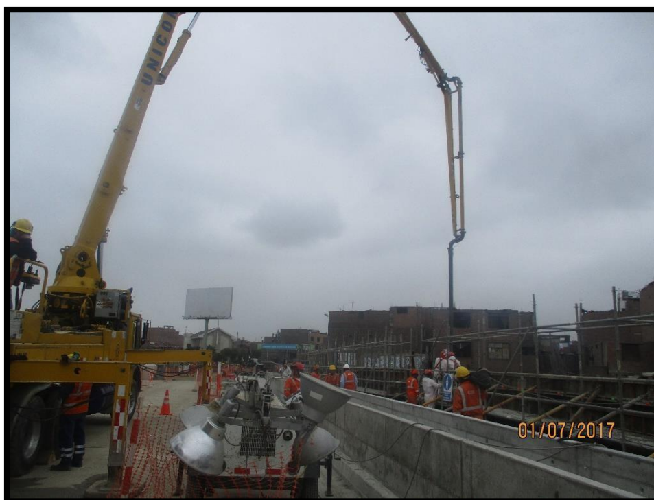
Figura 131 Vaciado de concreto en jardinera con f'c = 280 \text{ kg/cm}^2 .
