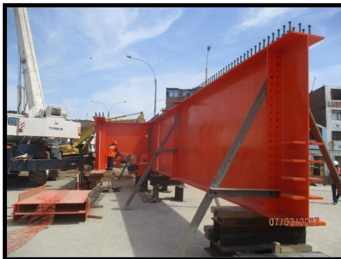
Figura 93 Armado de vigas metálicas.
