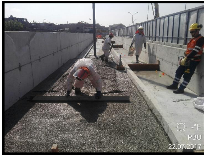
Figura 150 Vaciado de concreto para la vereda f'c=175 kg/cm 2 .
