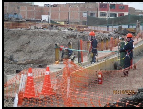
Figura 35 Retiro de barandas, guardavías y mallas de protección.
