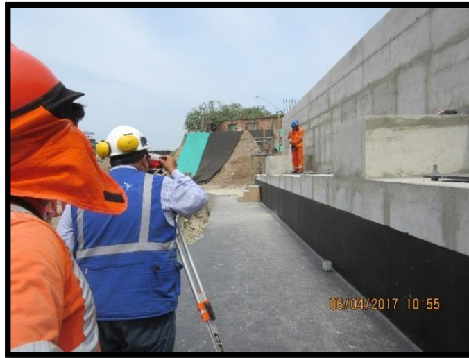
Figura 85 Verificación del nivel de las planchas metálicas.
