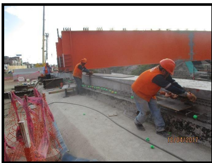
Figura 107 Inicio de desplazamiento horizontal del 1er grupo de vigas 11, 12 y 13.
