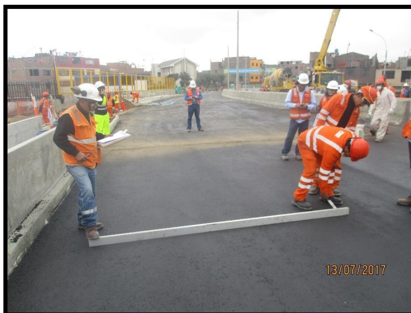
Figura 143 Medida de la regularidad superficial del pavimento.
