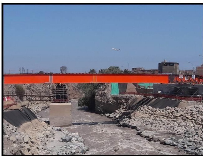
Figura 106 Lanzamiento del 1er grupo de vigas 11, 12 y 13 concluido.
