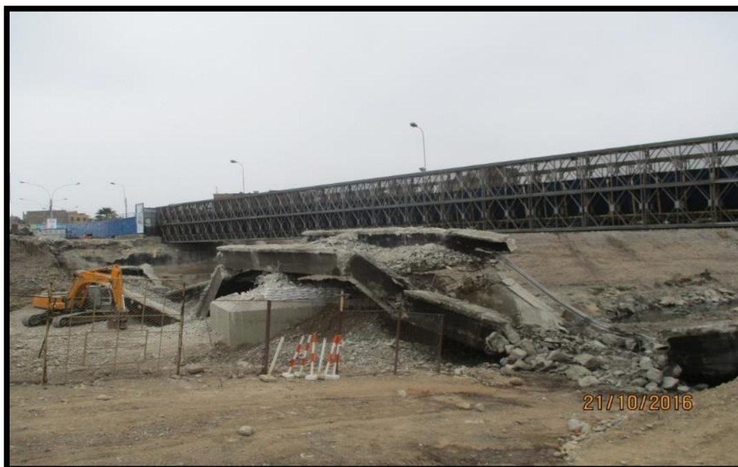
Figura 40 Demolición del tablero.
