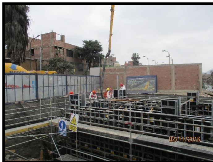
Figura 29 Vaciado de concreto f'c = 280 \text{ kg/cm}^2 de zapata y pantalla del estribo.
