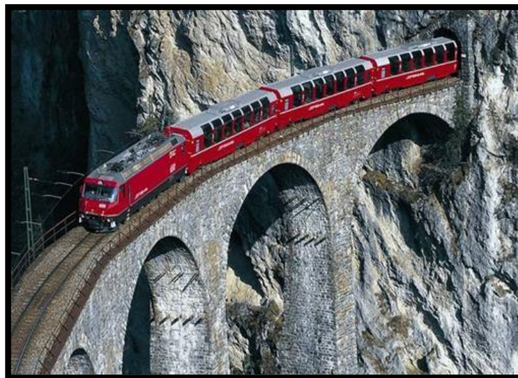
Figura 2 Puente para trenes.
