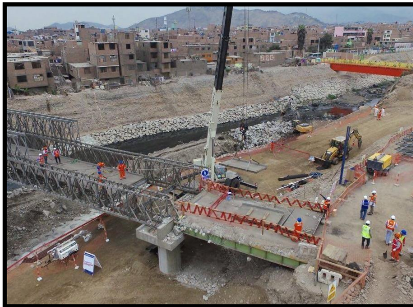
Figura 44 Retiro de paneles de piso.
