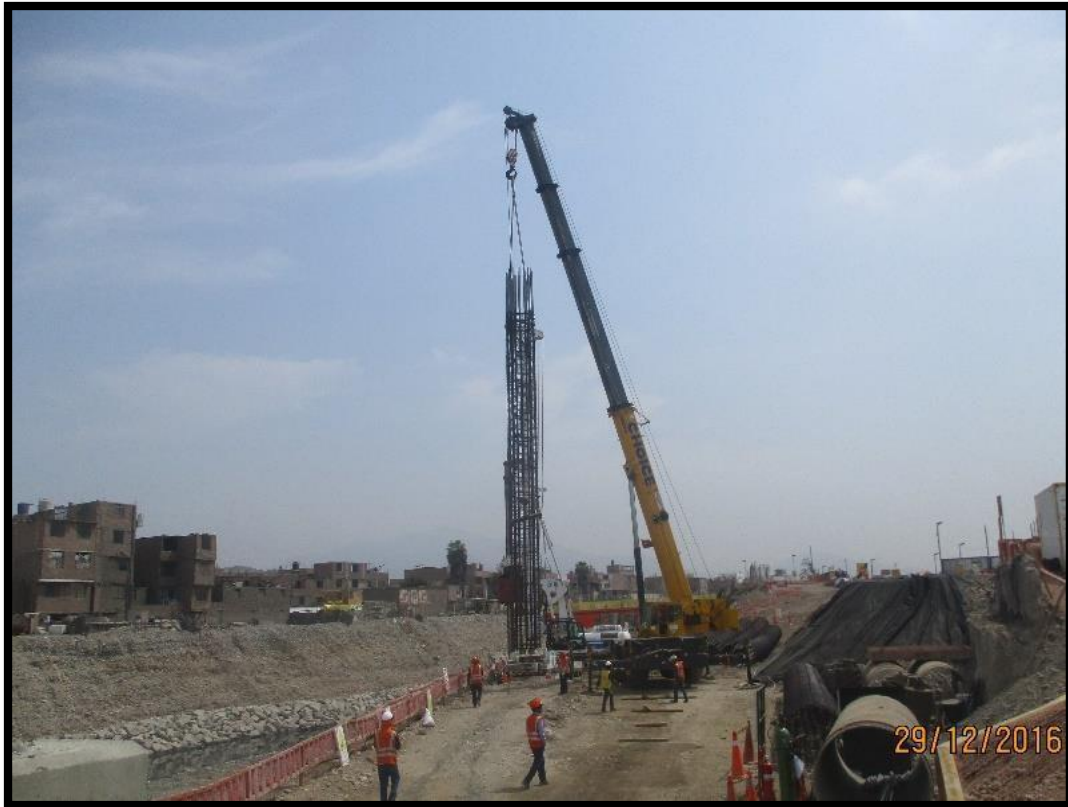
Figura 58 Colocación de la armadura de pilotes.
