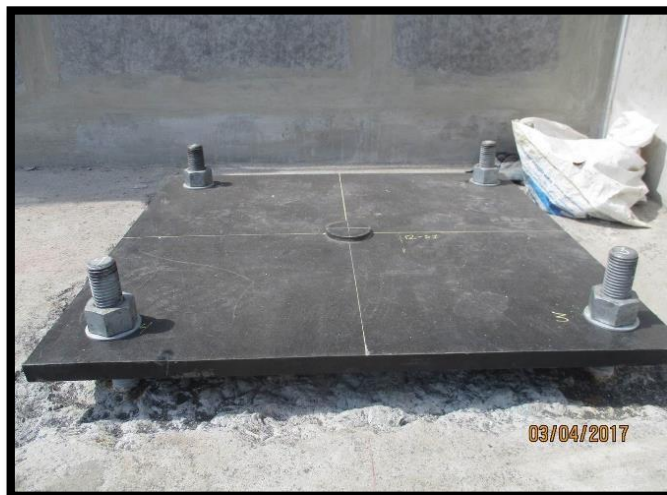
Figura 86 Plancha metálica en su ubicación final.
