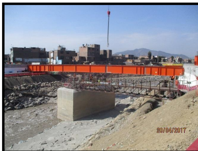
Figura 113 Culminación de la colocación del 1er grupo de vigas metálicas.
