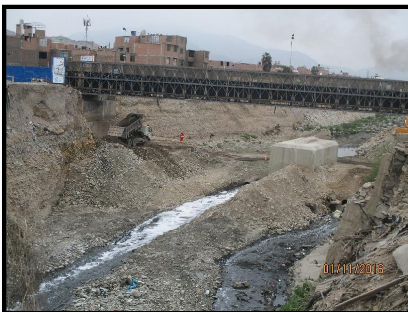
Figura 52 Inicio del relleno estructural Estribo 2.
