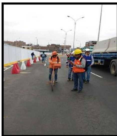
Figura 141 Determinación de la rugosidad superficial del pavimento.
