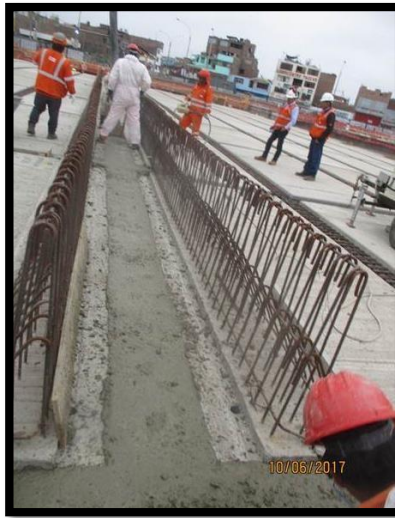
Figura 127 Vaciado de concreto con f'_c = 350 \text{ kg/cm}^2 en vigas de amarre.
