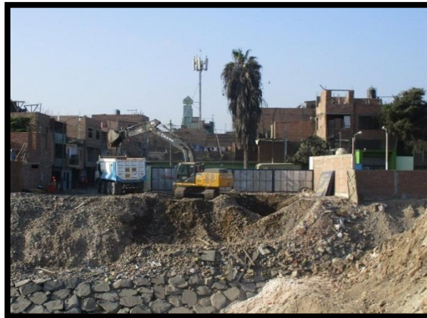
Figura 25 Excavación hasta la cota de fondo de la zapata.
