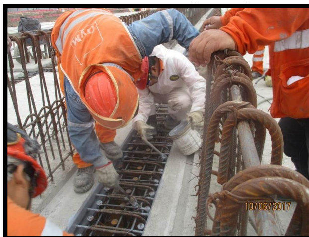
Figura 126 Colocación de puente de adherente para las vigas de amarre.
