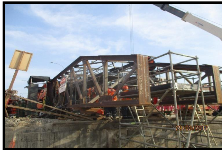
Figura 103 Colocación de la nariz de lanzamiento.
