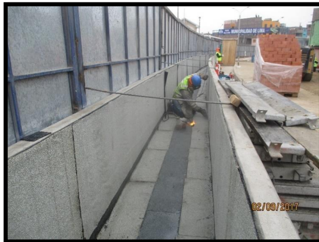
Figura 147 Colocación de manta asfáltica.
