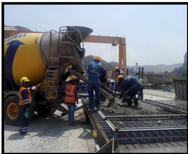
Figura 120 Vaciado de concreto f'c=300 para losas prefabricadas.
