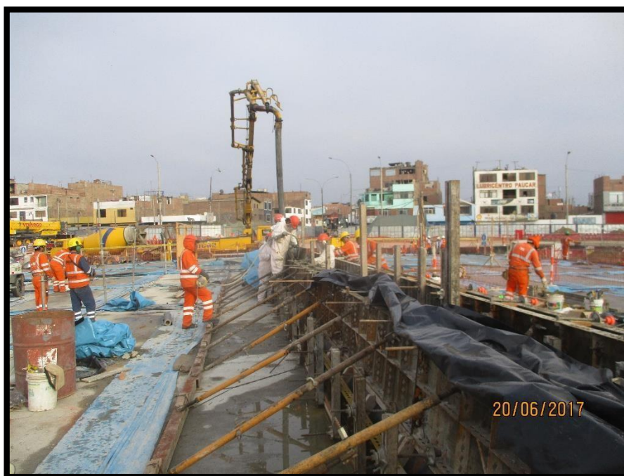
Figura 130 Vaciado de concreto de barrera new jersey con f'c = 300 \text{ kg/cm}^2 .
