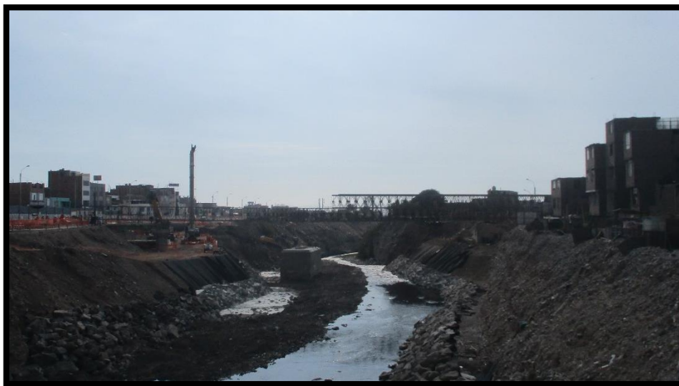
Figura 49 Inicio de desmontaje del Puente Bailey.
