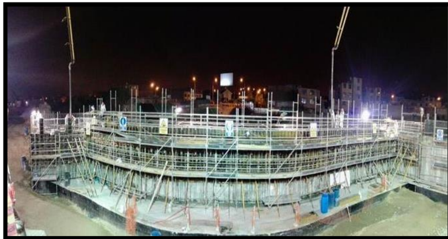
Figura 82 Vaciado de concreto f_c' = 280 \text{ kg/cm}^2 2da etapa de pantalla de estribo.
