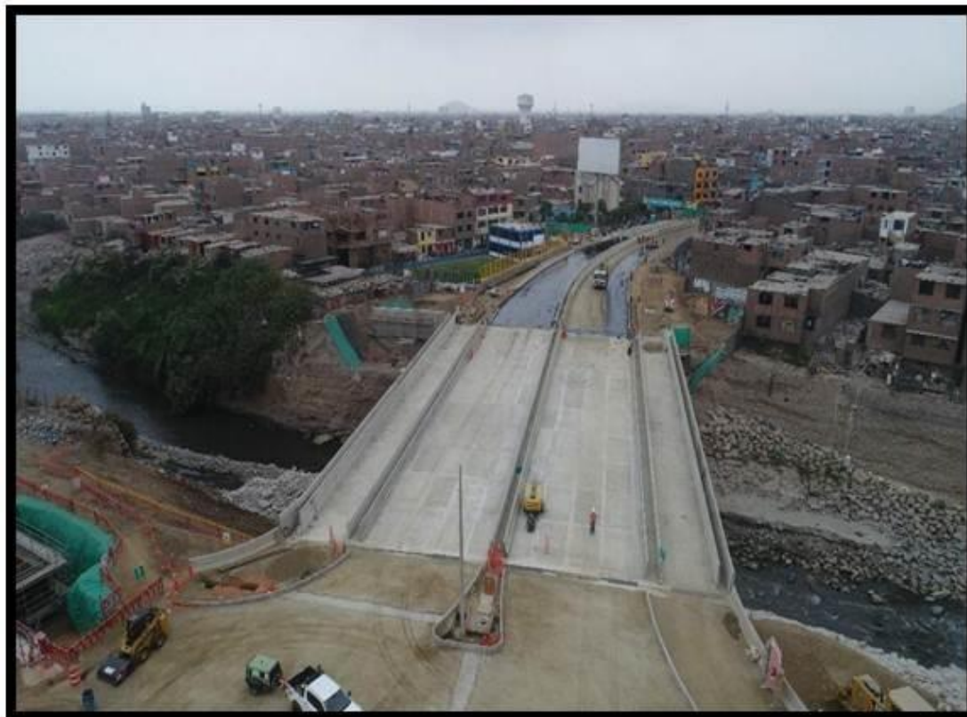
Figura 132 Vista del Puente Bella Unión sin asfaltar.
