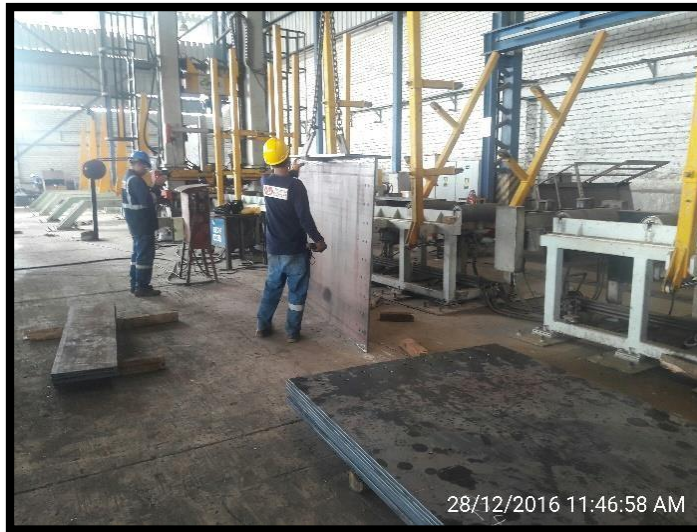
Figura 89 Inicio de los trabajos para la fabricación las vigas metálicas.
