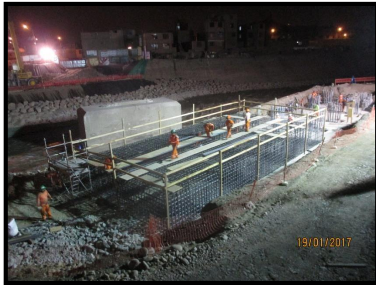
Figura 67 Colocación de acero para la zapata.
