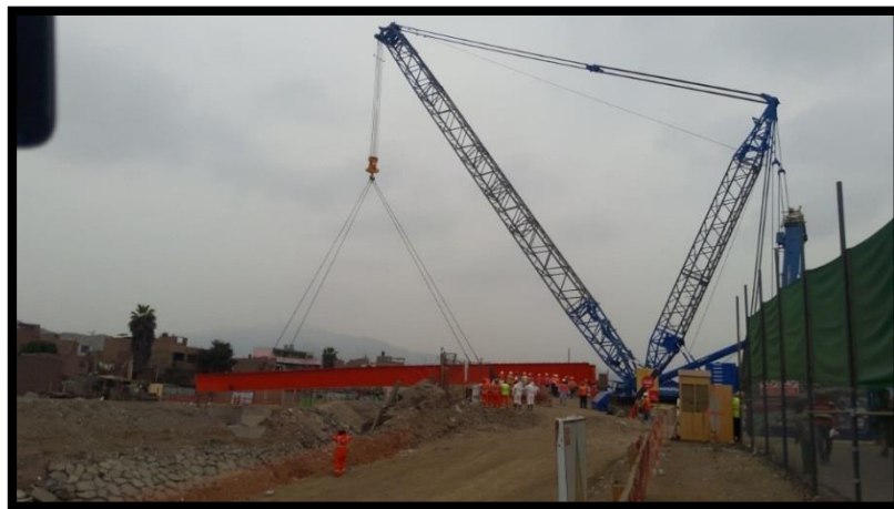
Figura 31 Montaje de viga metálica.
