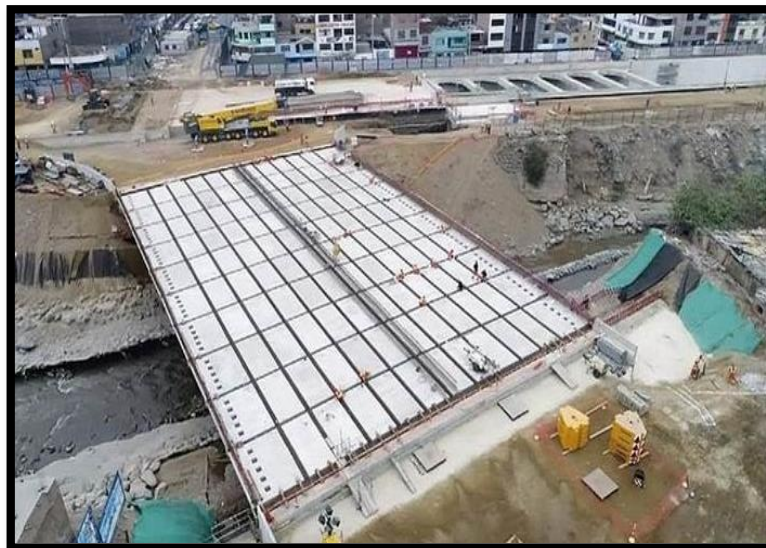
Figura 124 Vista final de la colocación de las losas prefabricadas.
