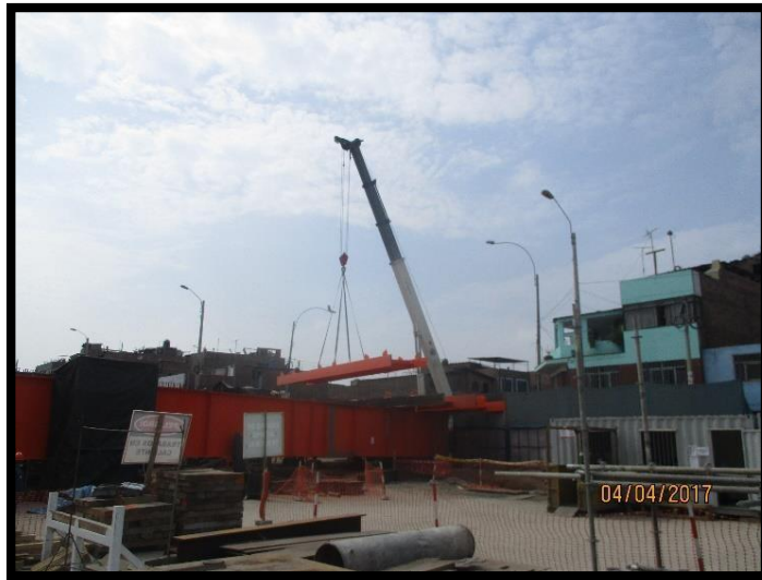
Figura 104 Colocación de contrapeso para lanzamiento.
