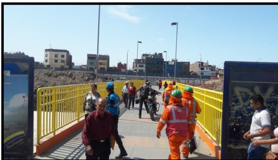
Figura 33 Habilidad del Puente Peatonal "Esmeralda"
