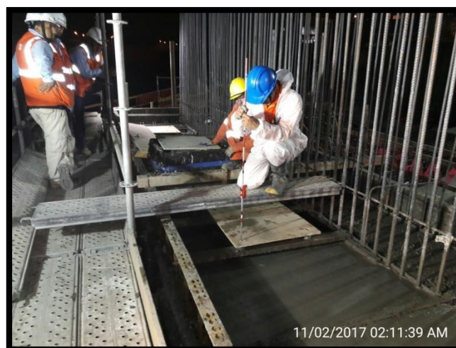
Figura 79 Verificación topográfica en los pernos de anclaje durante el vaciado del concreto.
