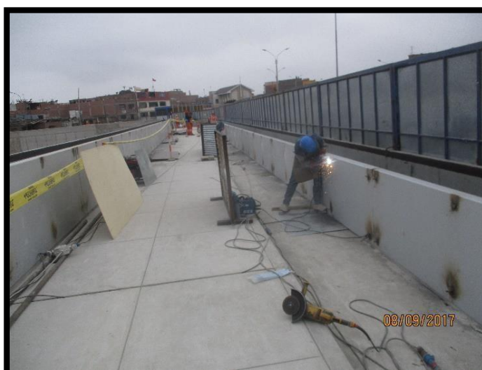
Figura 149 Colocación de plancha metálica en jardineras.
