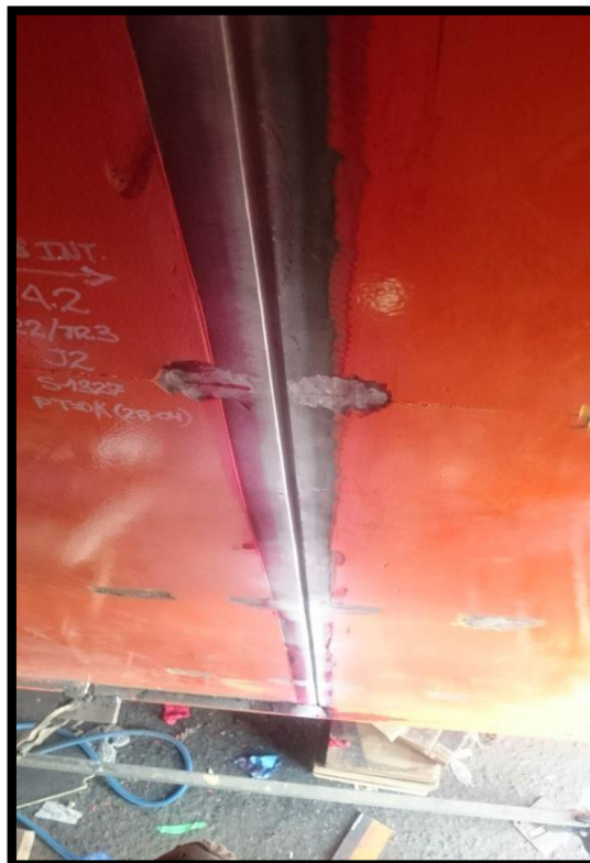
Figura 100 Ensayo de Tinte Penetrante.
