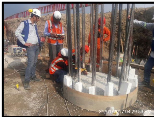
Figura 63 Ensayo de Integridad de Pilotes (PIT).
