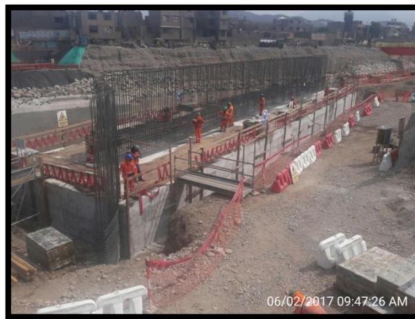
Figura 75 Colocación de acero para el apoyo de las vigas.
