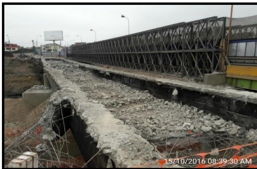
Figura 38 Demolición de la losa central de la viga cajón.
