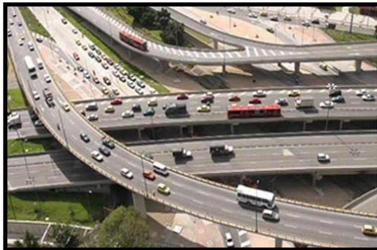
Figura 4 Puente para vehículos
