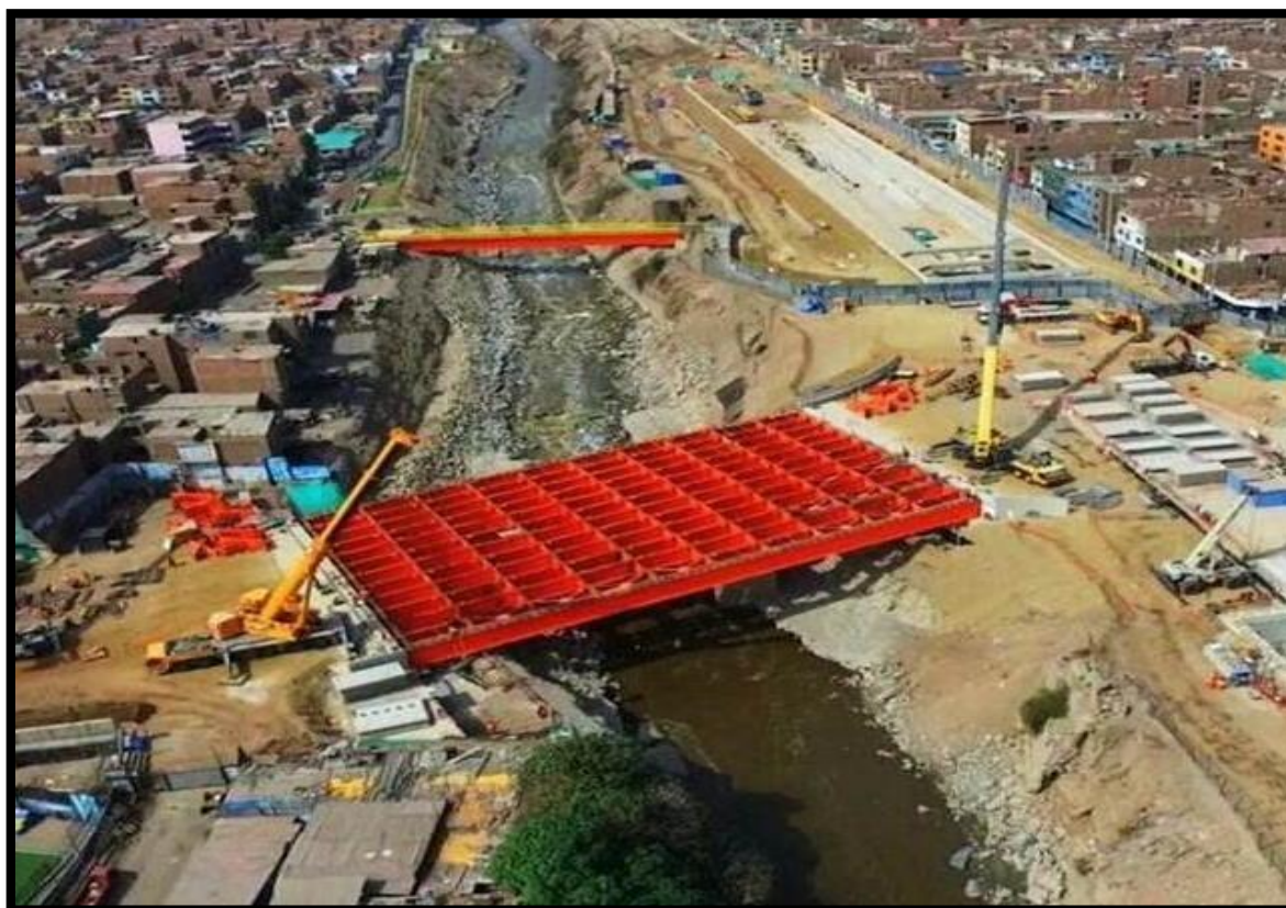
Figura 117 Vista final de las vigas metálicas colocadas.
