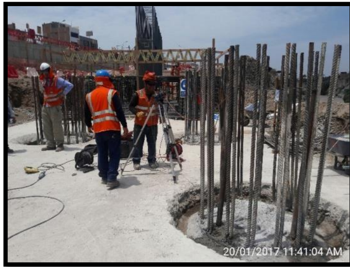
Figura 62 Ensayo de Ultrasonico Cross Hole.
