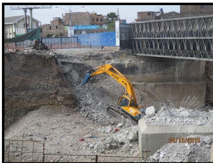
Figura 41 Demolición del Estribo Existente.
