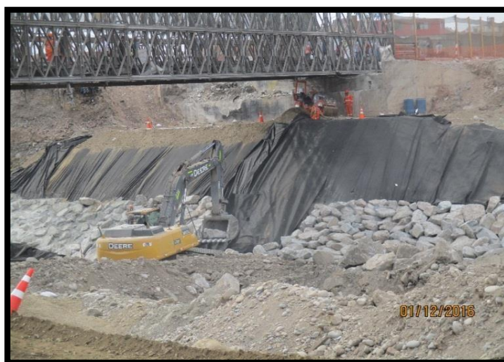
Figura 54 Colocación de roca para enrocado provisional.
