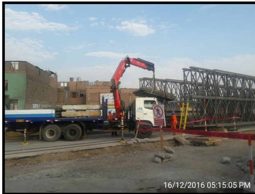
Figura 46 Colocación del contrapeso
