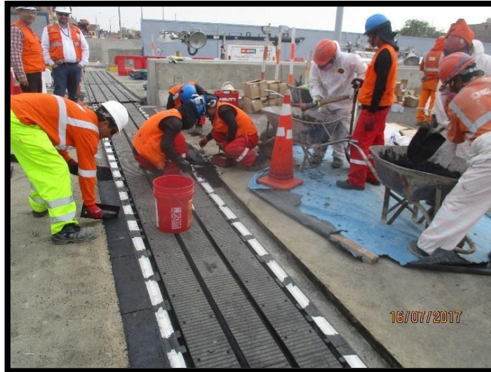
Figura 138 Colocación de junta transfer.
