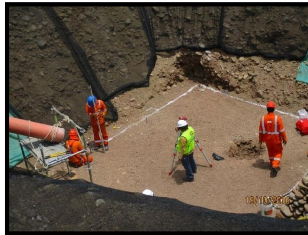
Figura 26 Ejecutaron los trabajos de trazo y replanteo para zapata.
