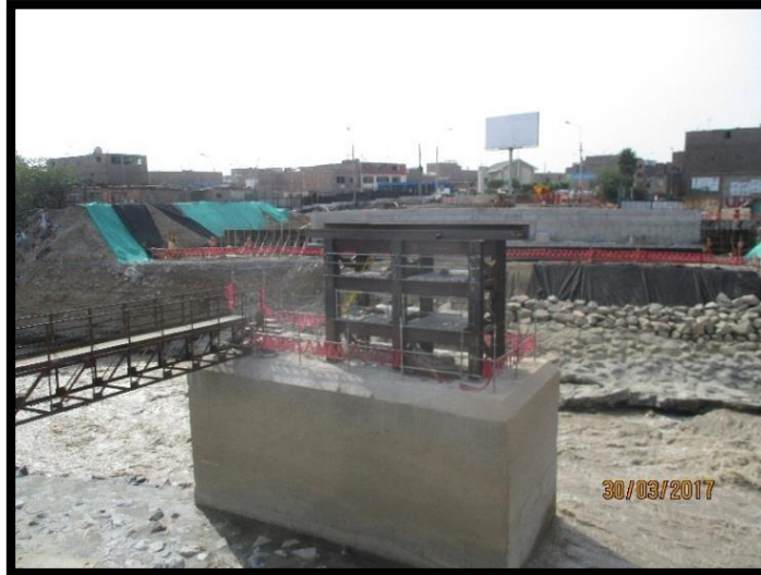
Figura 102 Apoyo en el rio para lanzamiento de las vigas metálicas.
