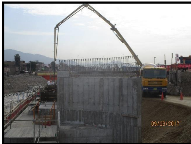
Figura 84 Vaciado de concreto de f'c = 280 \text{ kg/cm}^2 para topes.
