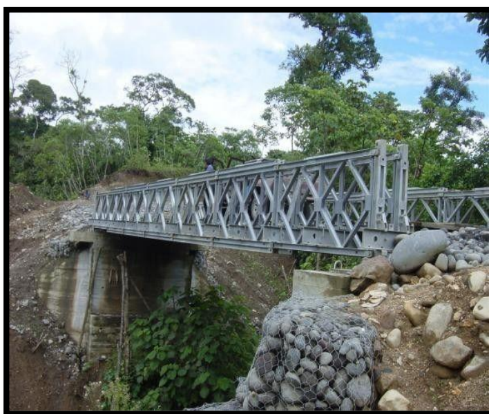
Figura 16 Puente Tipo Acrow
