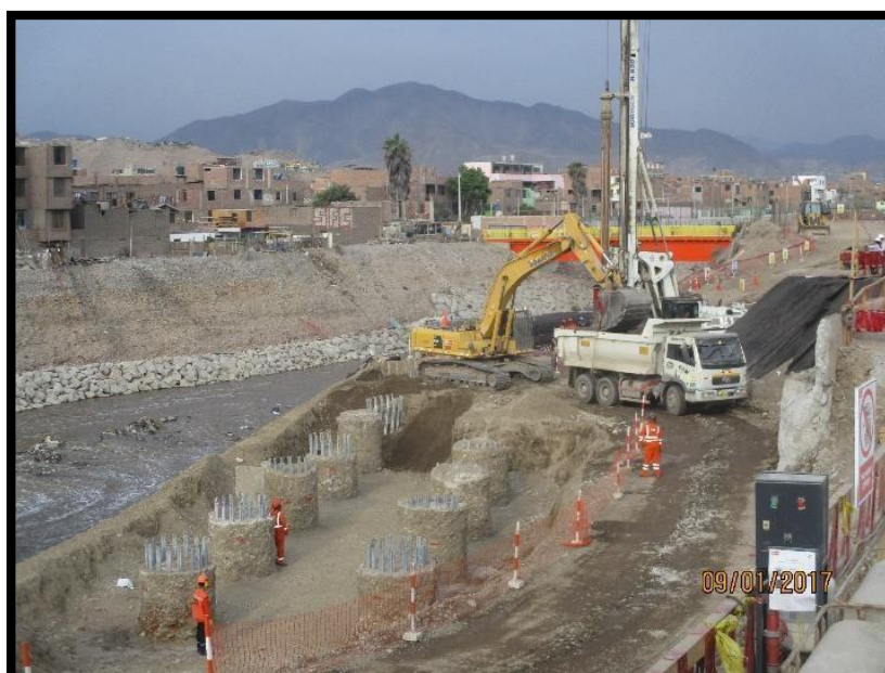
Figura 60 Excavación para descabezado de Pilotes
