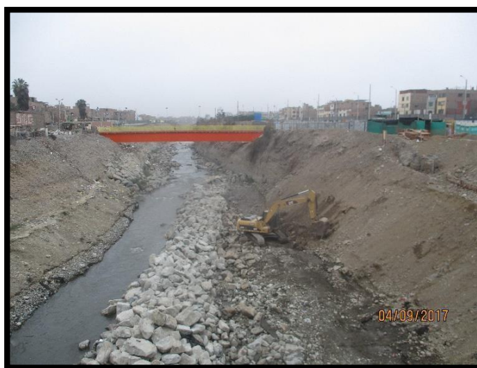
Figura 148 Trabajos de enrocado definitivo.
