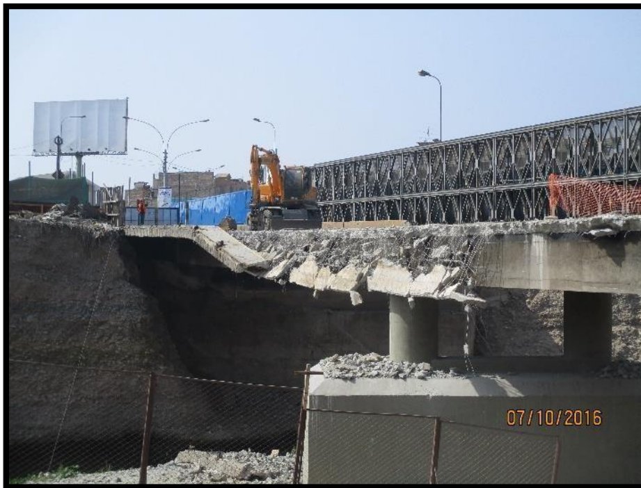
Figura 37 Demolición de aleros.
