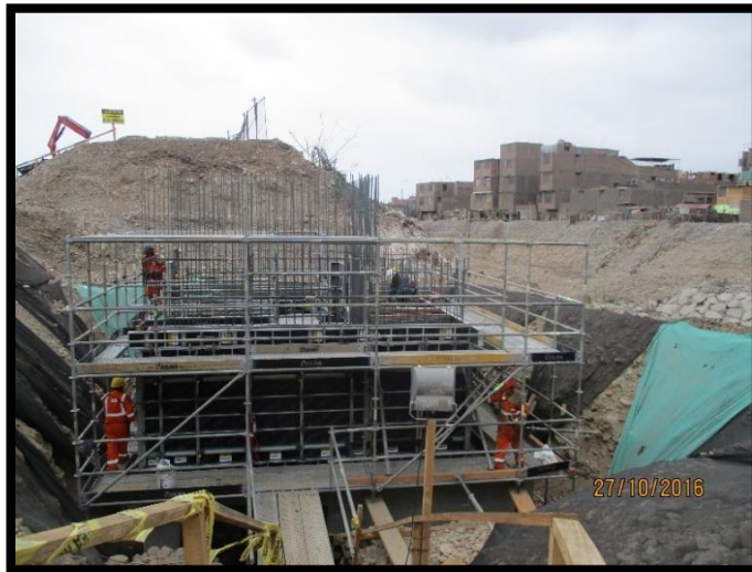
Figura 28 Encofrado para la zapata y estribo.
