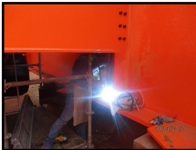
Figura 92 Trabajos de soldadura en vigas metálicas.
