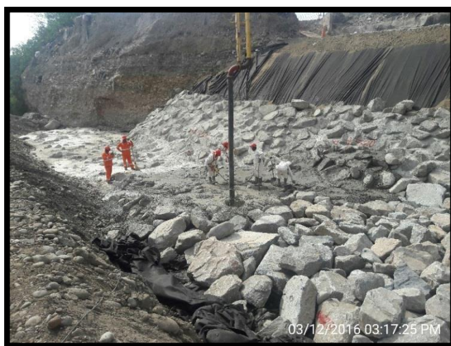
Figura 55 Colocación de concreto f'c = 210 \text{ kg/cm}^2 para enrocado provisional.
