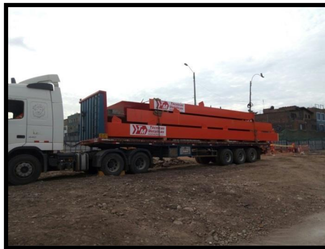
Figura 90 Llegada de las vigas metálicas a obra.
