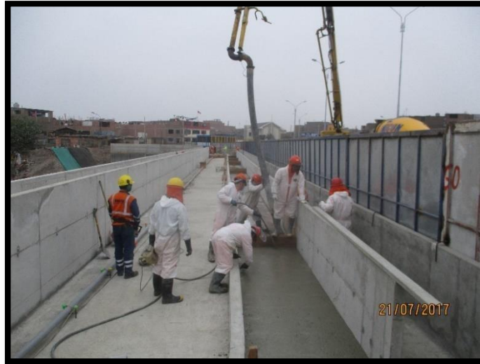
Figura 146 Vaciado de concreto para la ciclovía f_c'=175 kg/cm 2 .
