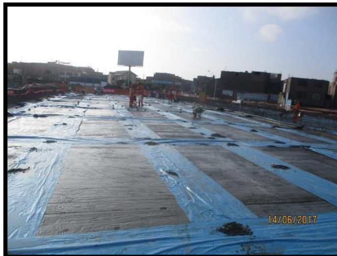
Figura 128 Curado de las vigas de amarre.
