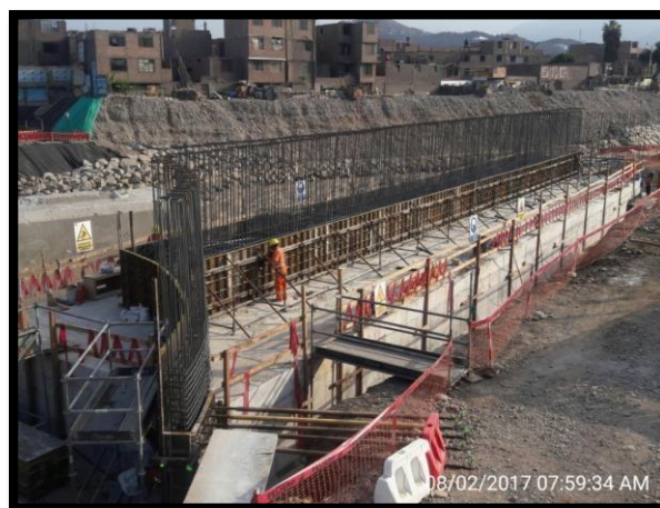
Figura 76 Encofrado para el apoyo de las vigas.
