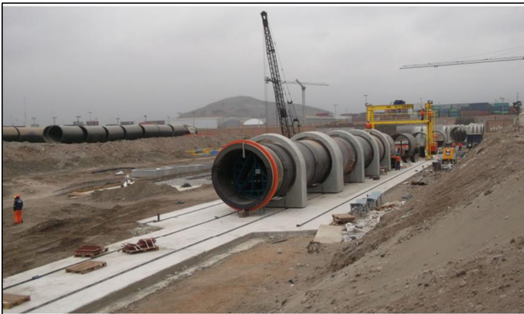
Figura 4. Emisor submarino en construcción, para ser lanzado al mar, febrero 2014.
