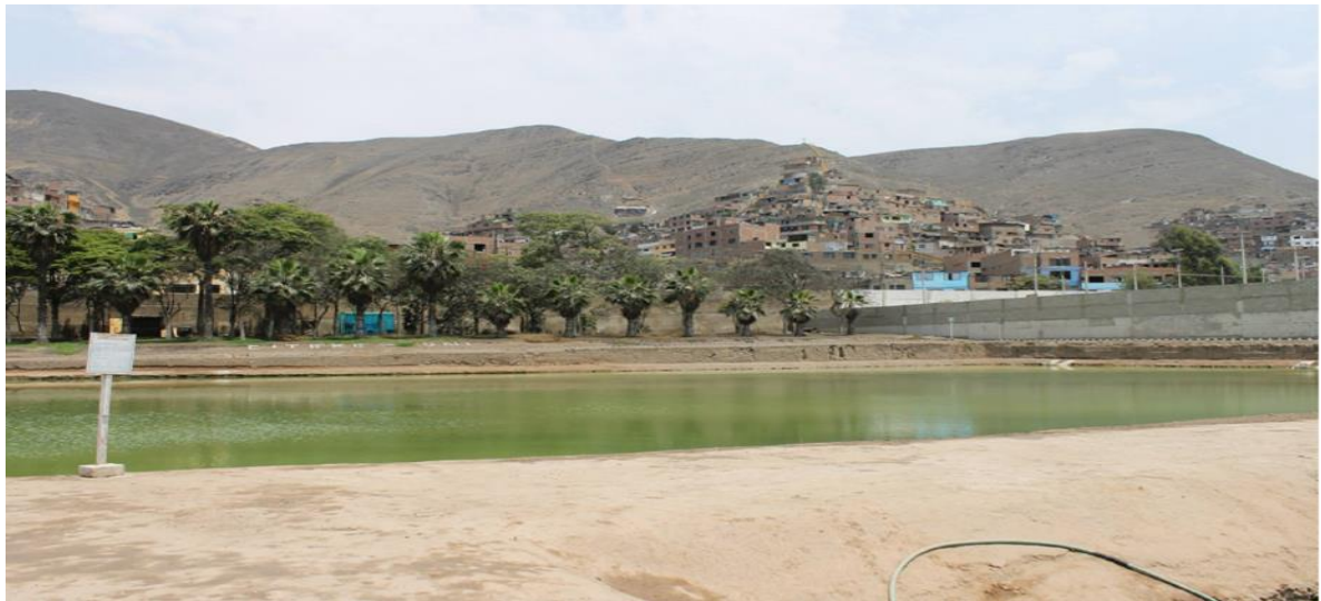
Foto 2. Planta de Tratamiento de Aguas residuales Citrar UNI Fuente: CITRAR UNI
