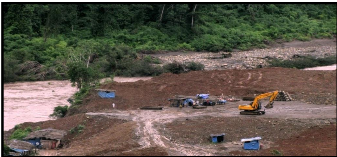
Figura 2. Maquinaria Pesada y Campamentos Precarios de Mineros Informales.
