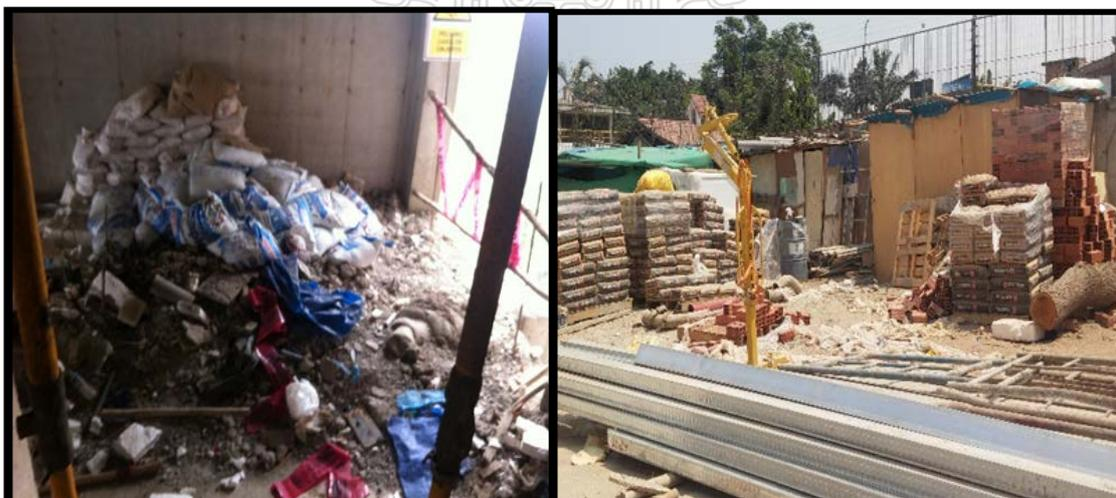
Figura 12. Acopio de materiales inadecuado
