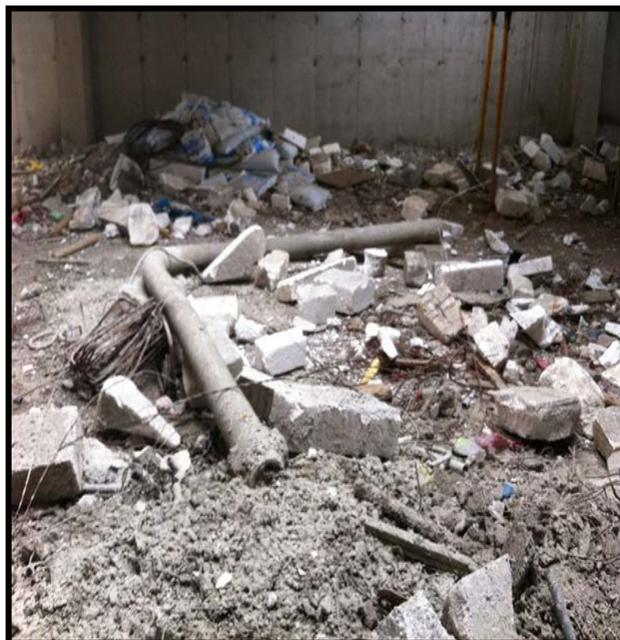
*Figura 15. Tuberías para bombeo concreto deterioradas.*
