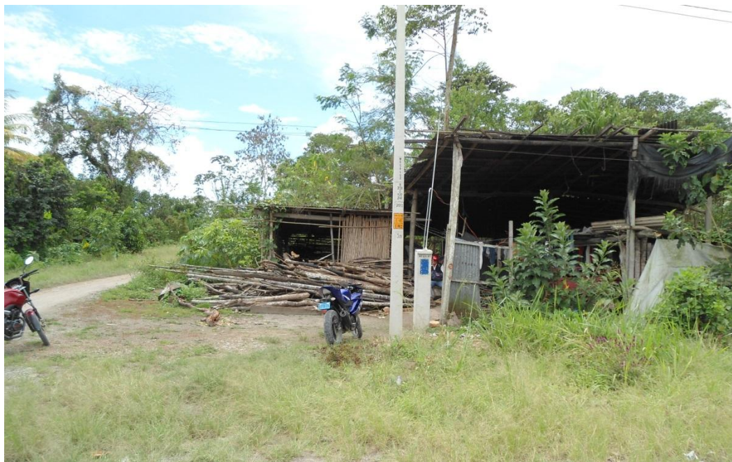
Imagen 6: Fragilidad de las viviendas en el Barrio bajo de Yuracyacu Fuente: Salida de campo 2016
