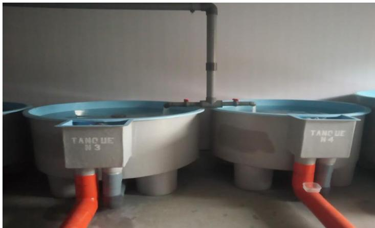
*Nota.* Instalación de las salidas de cada estanque circular.
