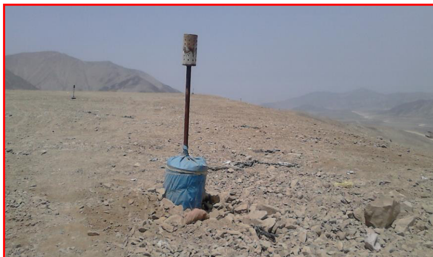
Chimenea y quemador
