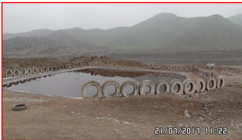
Poza de captación de lixiviados
