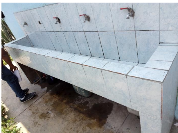
Caños en mal estado
