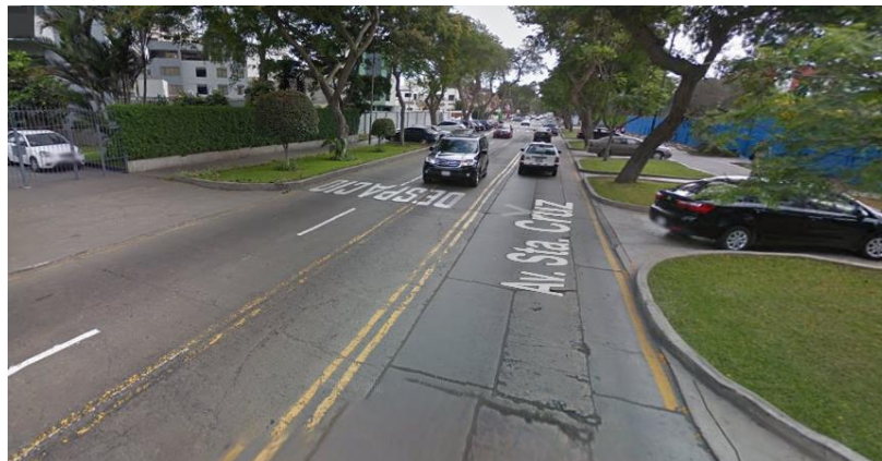
Figura N° 4. Características físicas de la Av. Santa Cruz
