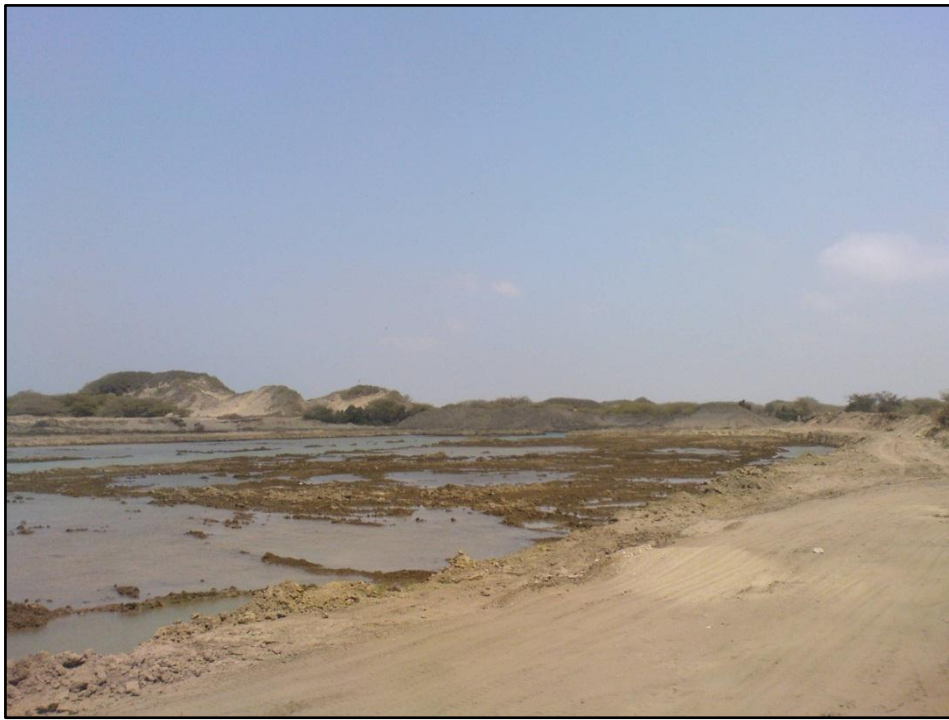
Foto N.º 01: Excavación inicial del terreno con presencia de agua.
