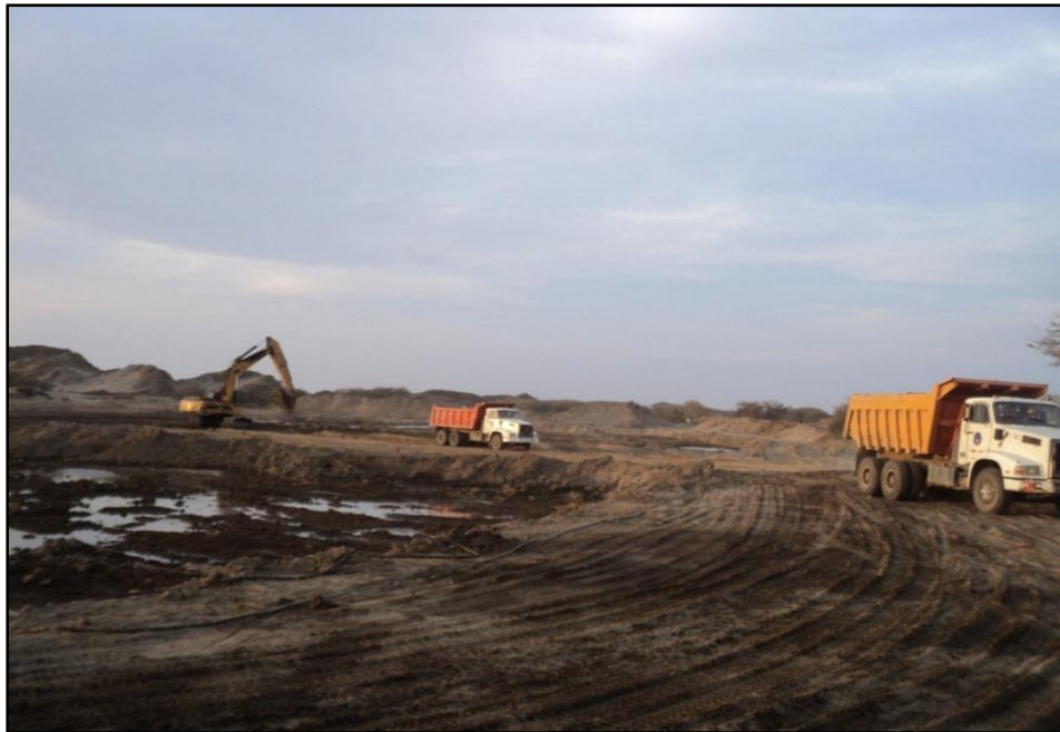
Foto N.º 03: Excavación masiva con presencia de napa freática.
