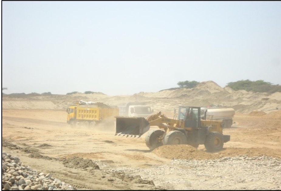
Foto N.º 22: Colocación de afirmado encima del over en fondo de la laguna
