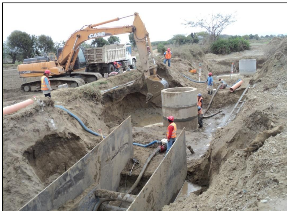
Foto N.º 10: Colocación y encimado de buzón pre fabricado en el emisor.
