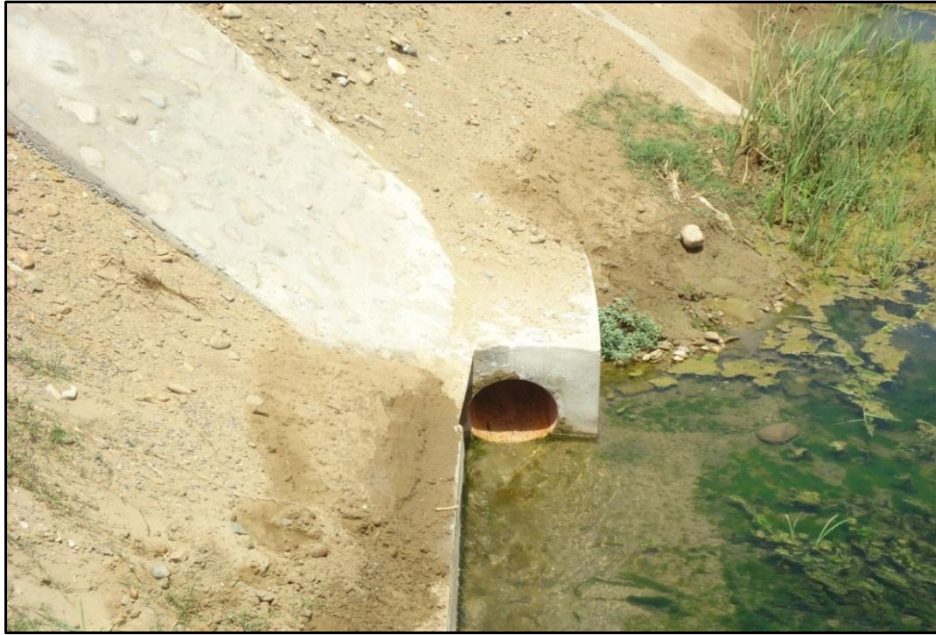
Foto N.º 07: Acabado final del punto de descarga del emisor
