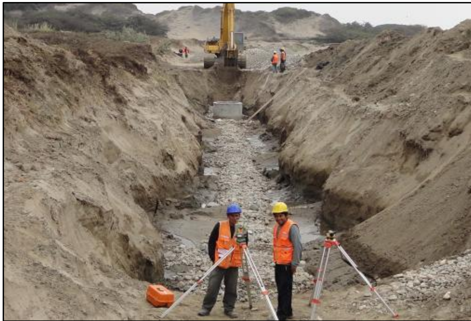
Foto N.º 15: Colocación de canto rodado interior y exterior del geotextil.
