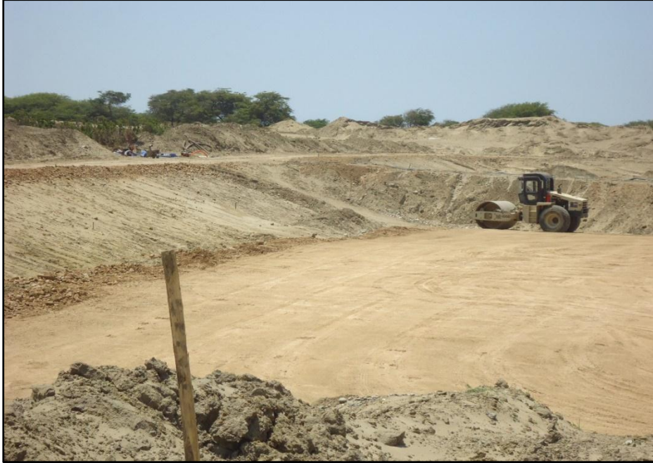
Foto N.º 24: Compactación del afirmado en fondo de laguna.
