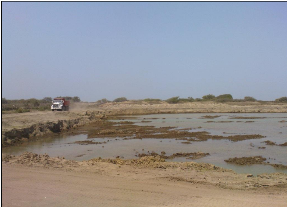
Foto N.º 02: Presencia de agua que imposibilita la Excavación.
