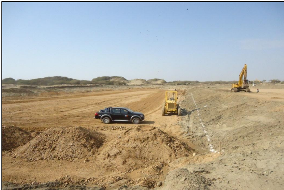
Foto N.º 23: Nivelación de afirmado en fondo de la laguna.
