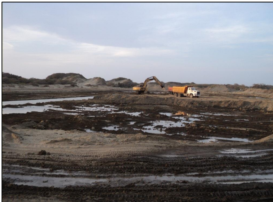
Foto N.º 04: Imposibilidad de continuar la excavación por la presencia la napa freática.
