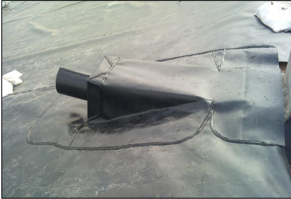
Foto N.º 40: Detalle de la unión de geomembrana por termofusión.
