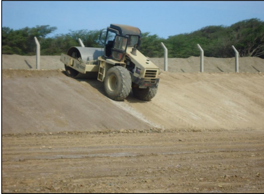
Foto N.º 30: Compactación final del afirmado de los taludes.
