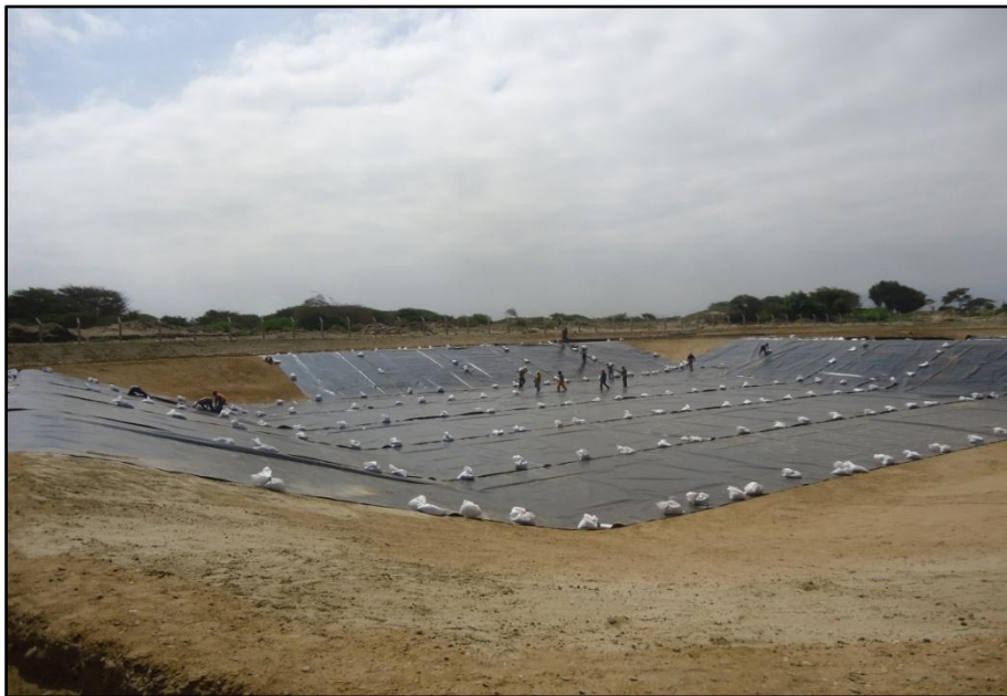
Foto N.º 37: Tendido de la geomembrana.
