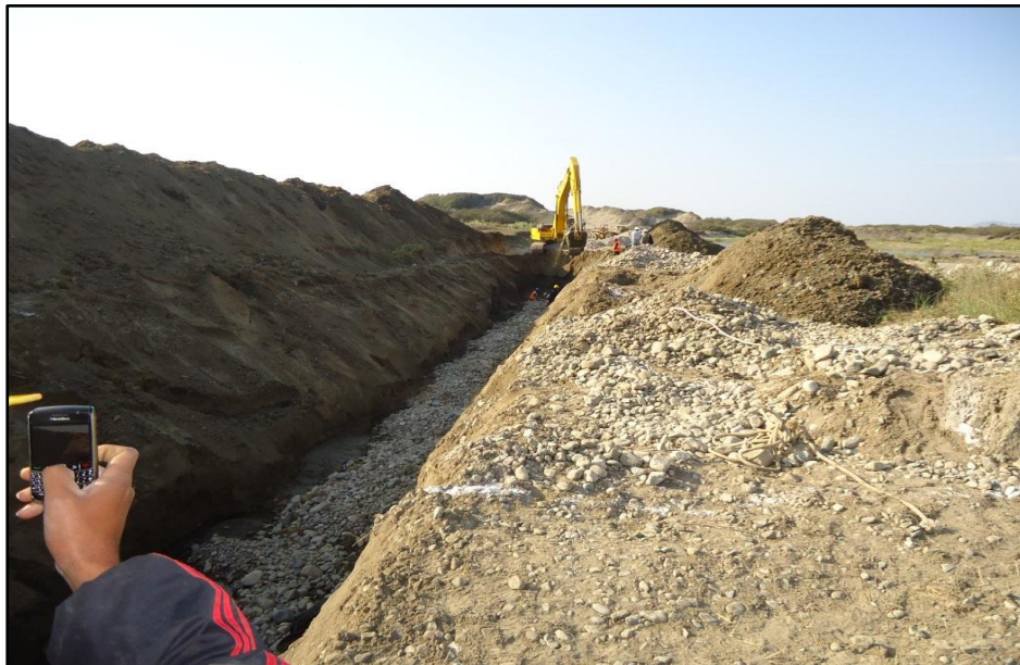
Foto N.º 09: Colocación de cantos rodados en el emisor
