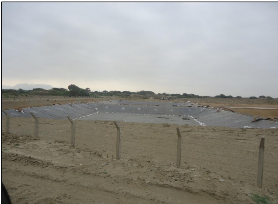
Foto N.º 39: Acabado de colocación de la geomembrana.
