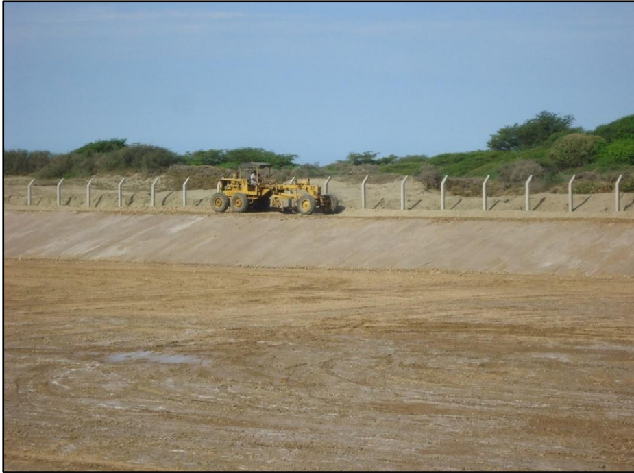
Foto N.º 32: Conformación de la coronación de los diques.
