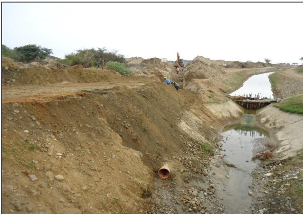
Foto N.º 06: Continuación de la construcción del emisor (Excavando y rellenando)
