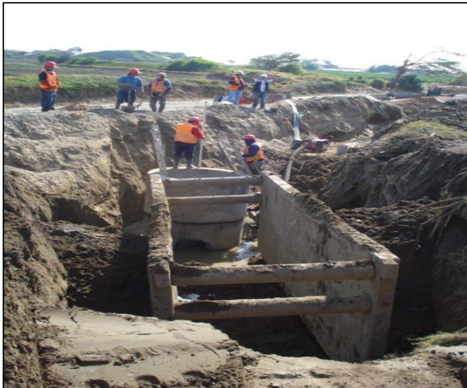
Foto N.º 12: Excavación de los drenes en el buzón inicial del emisor.
