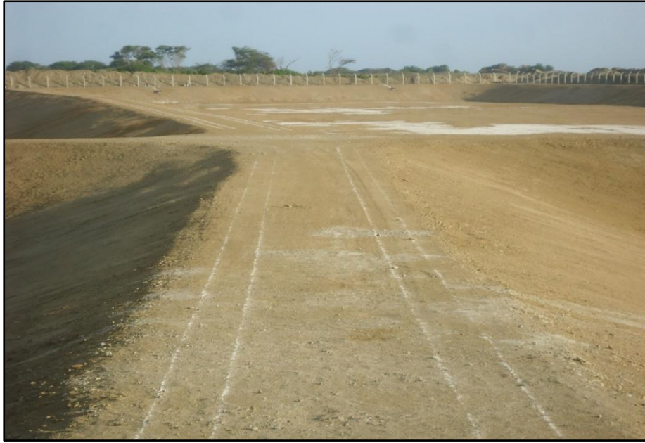
Foto N.º 36: Trazado de zanja para anclaje de geomembrana.
