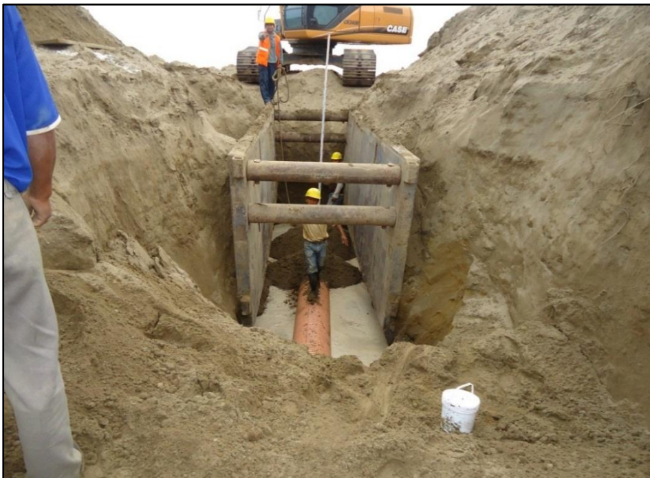
Foto N.º 08: Continuación de la excavación del emisor aguas arriba.
