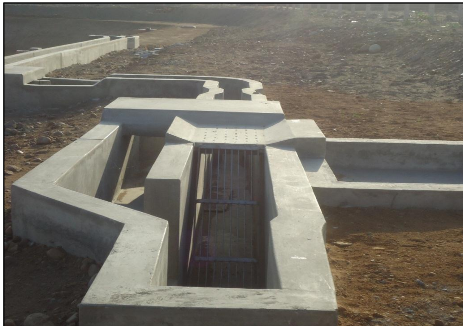
Foto N.º 35: Obras de arte (cámara de rejillas, canaleta parshall, by-pass)
