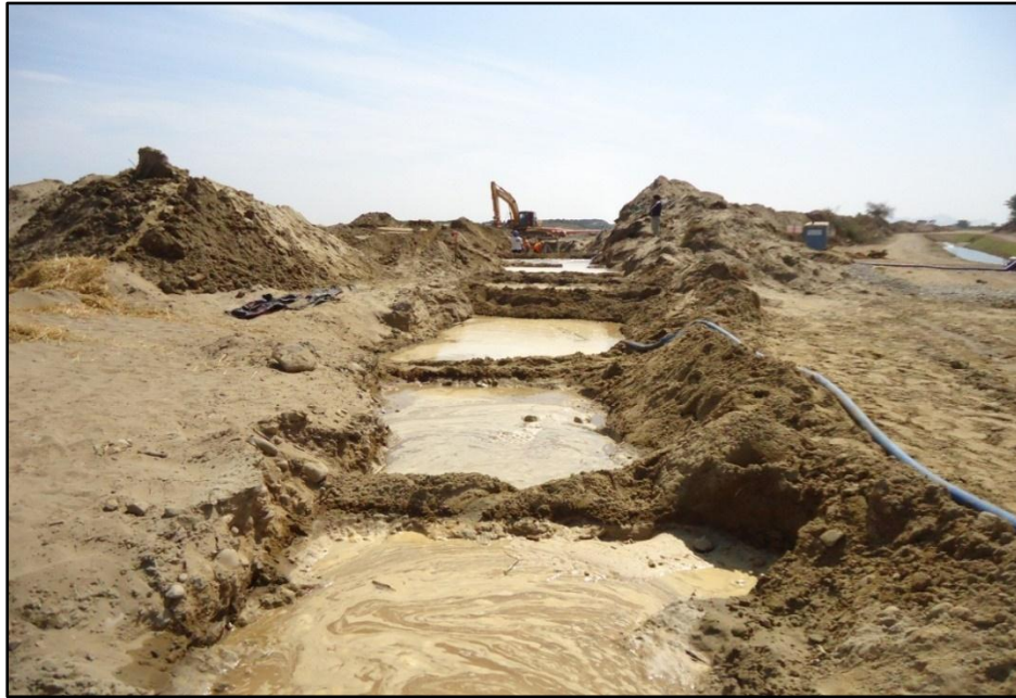
Foto N.º 11: Compactación del relleno del emisor.
