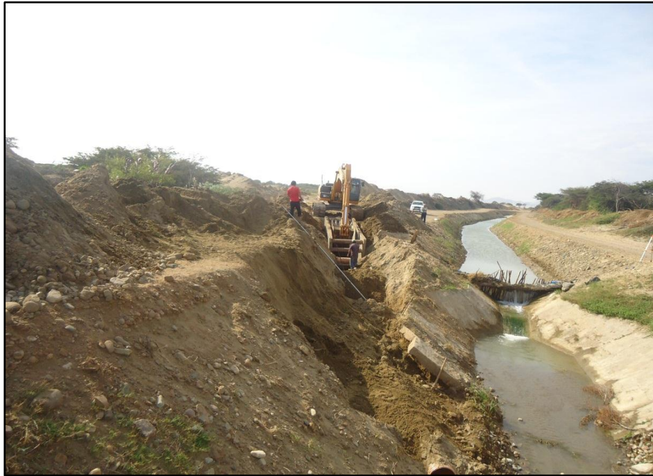
Foto N.º 05: Inicio de la excavación del emisor en su punto de descarga en canal existente.
