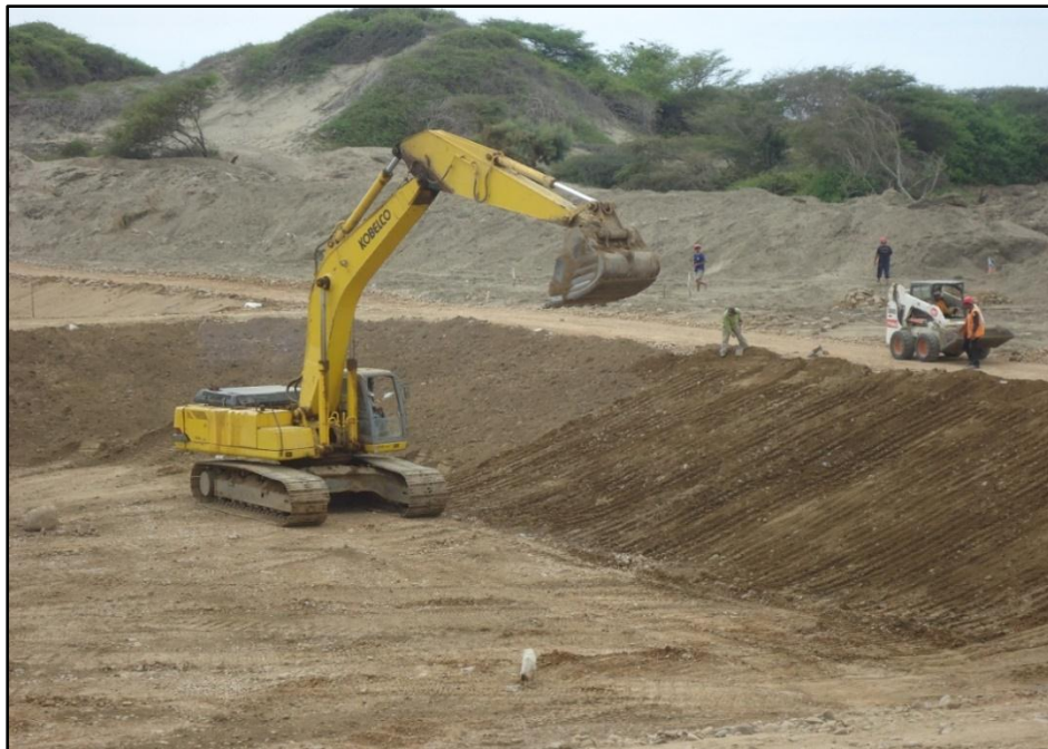
Foto N.º 27: Colocación de over en los taludes en terreno natural.
