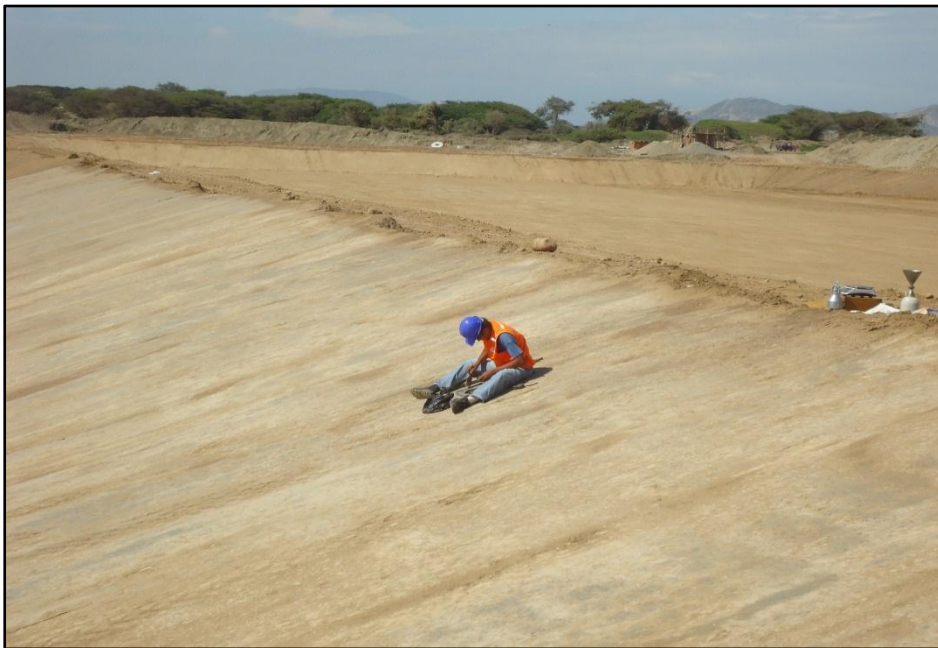
Foto N.º 31: Prueba de compactación de talud.
