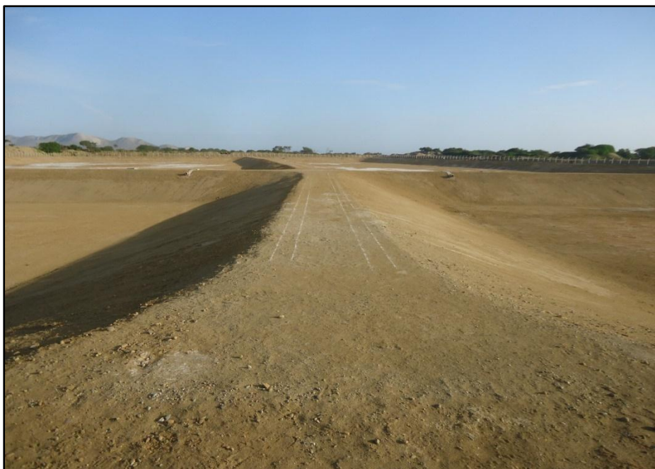
Foto N.º 34: Vista panorámica de las lagunas en afirmado. (Taludes, coronación y fondos)
