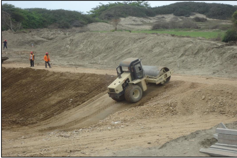
Foto N.º 28: Compactación de over colocado en los taludes.
