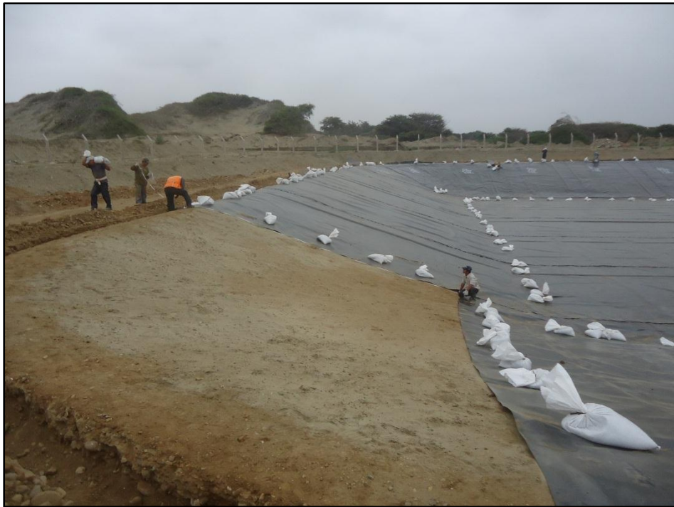
Foto N.º 38: Anclaje de la geomembrana.
