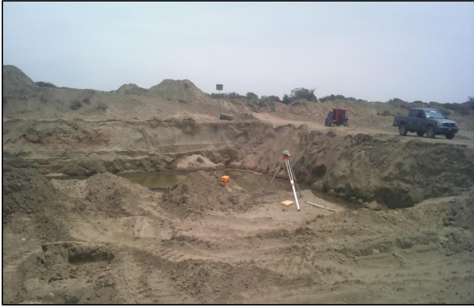
Foto N.º 17: Comprobación topográfica del nivel de fondo de excavación.
