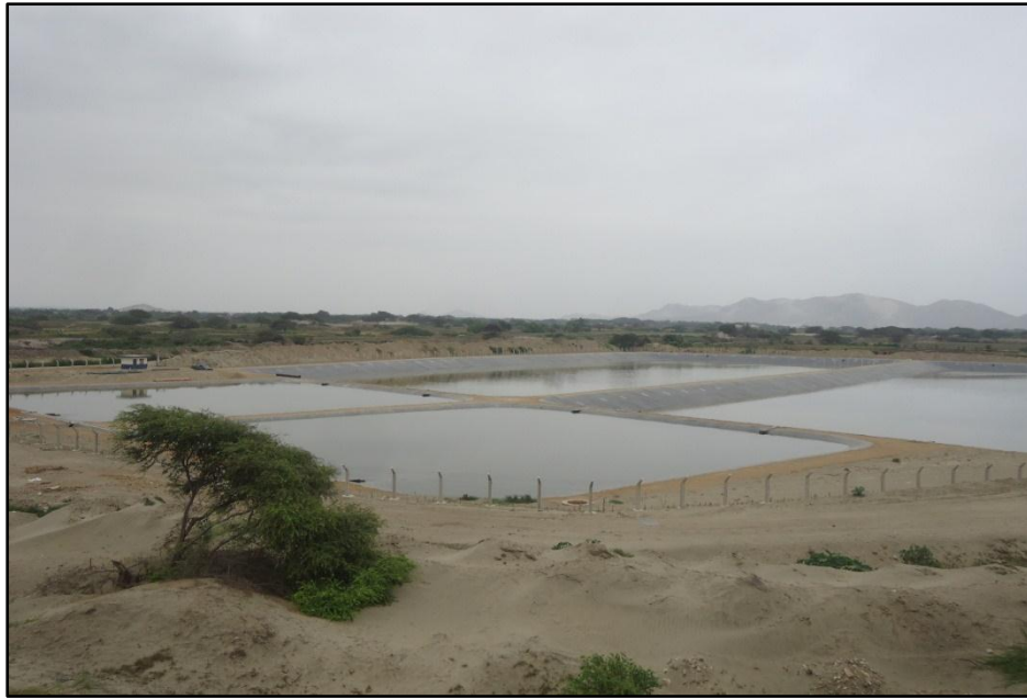
Foto N.º 44: Vista panorámica de las cuatro lagunas construidas en funcionamiento.
