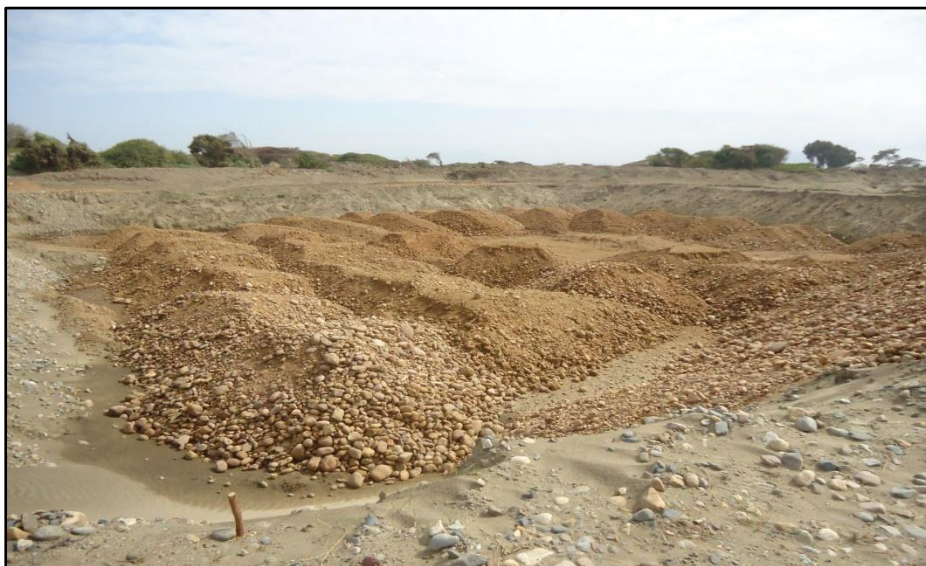
Foto N.º 19: Colocación masiva de over en el fondo de la laguna.
