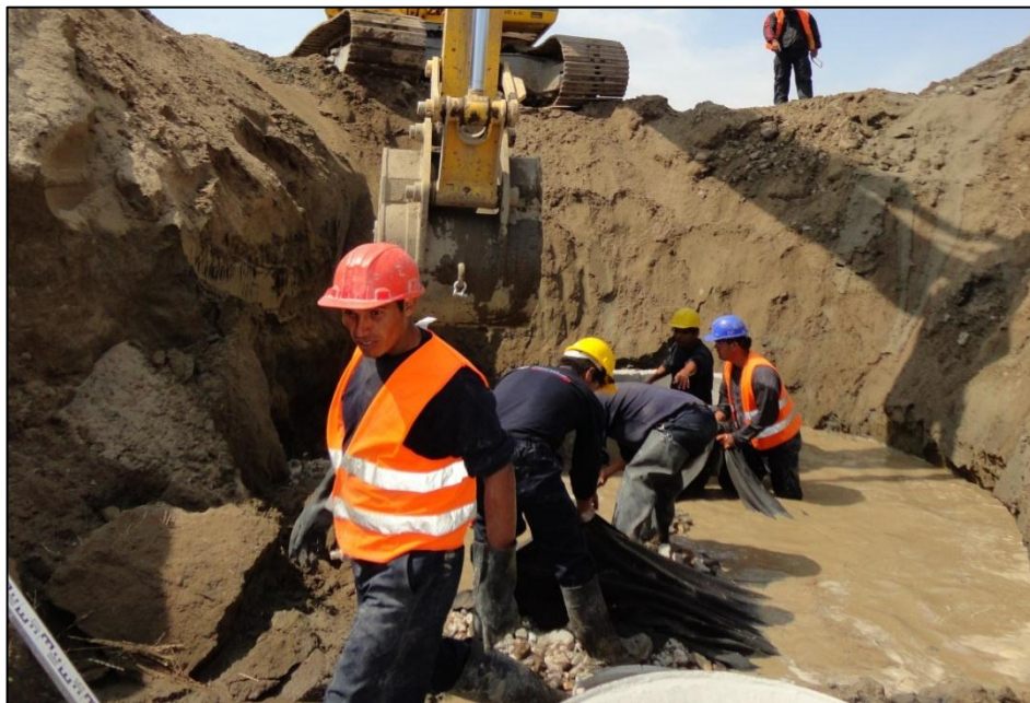
Foto N.º 14: Colocación del Geotextil en los drenes.
