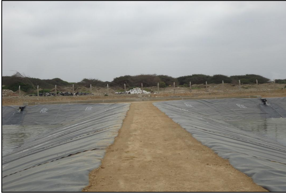
Foto N.º 42: Vista del llenado de lagunas desde la coronación.
