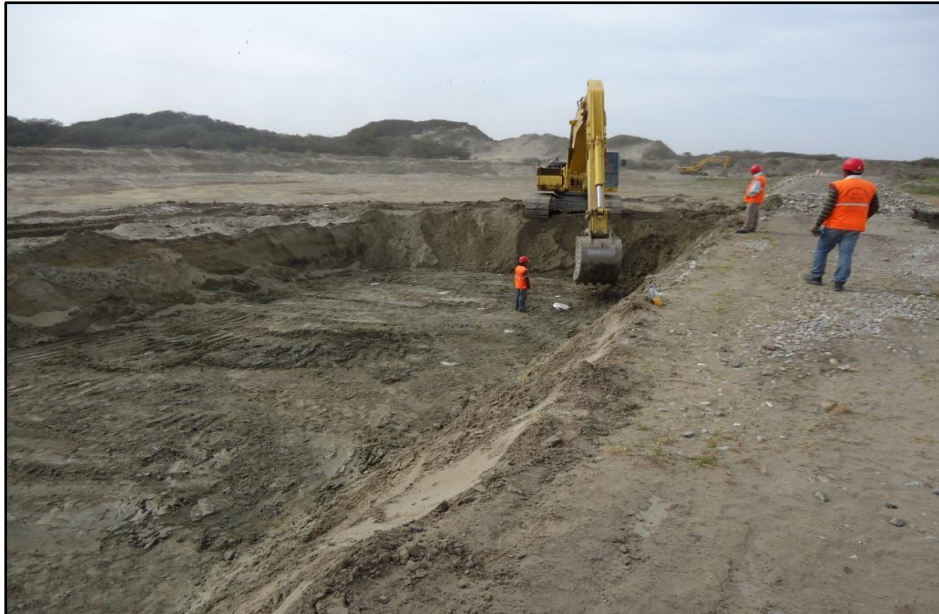
Foto N.º 18: Excavación del fondo sin presencia de la napa freática
