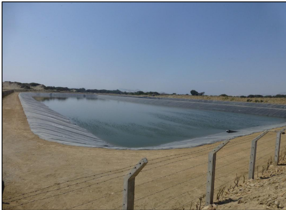
Foto N.º 45: Vista panorámica de las cuatro lagunas construidas en funcionamiento.
