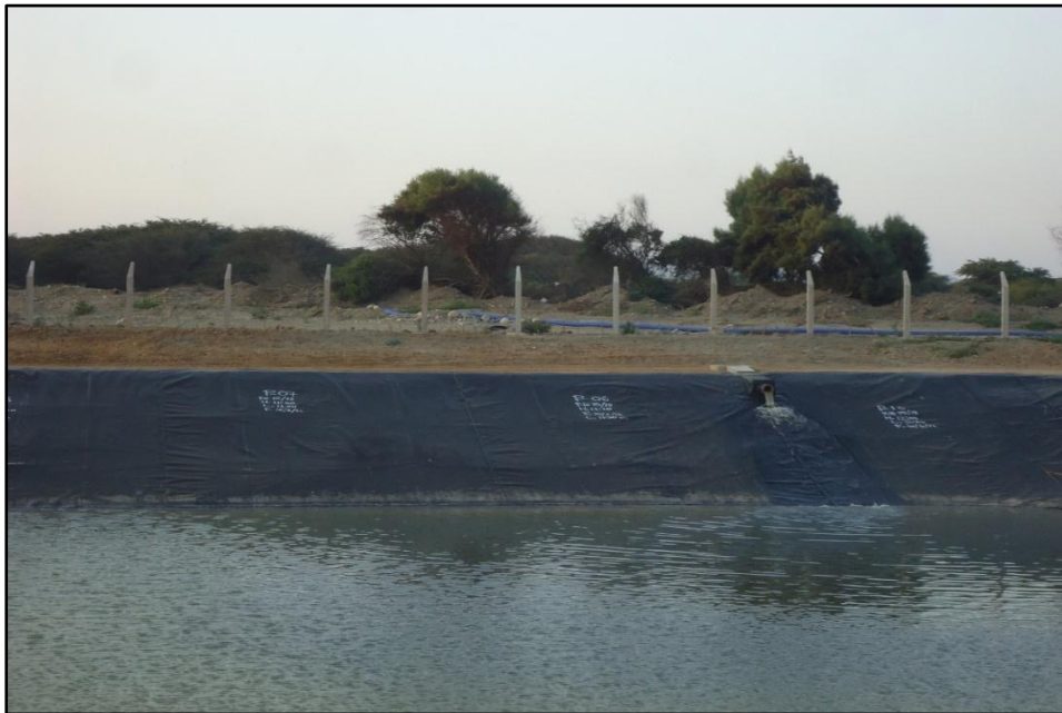
Foto N.º 41: Llenado de lagunas.
