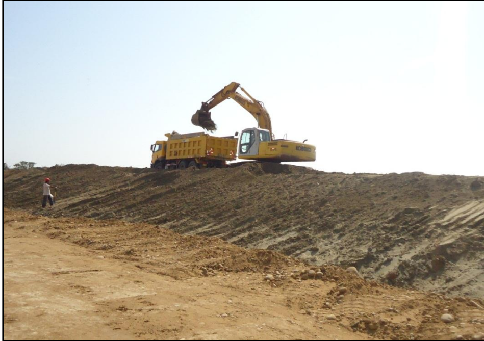
Foto N.º 26: Eliminación de excedentes de la conformación de talud en terreno natural.
