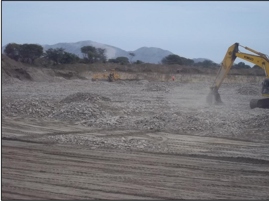
Foto N.º 20: Distribución y nivelación del over en el fondo de la laguna.
