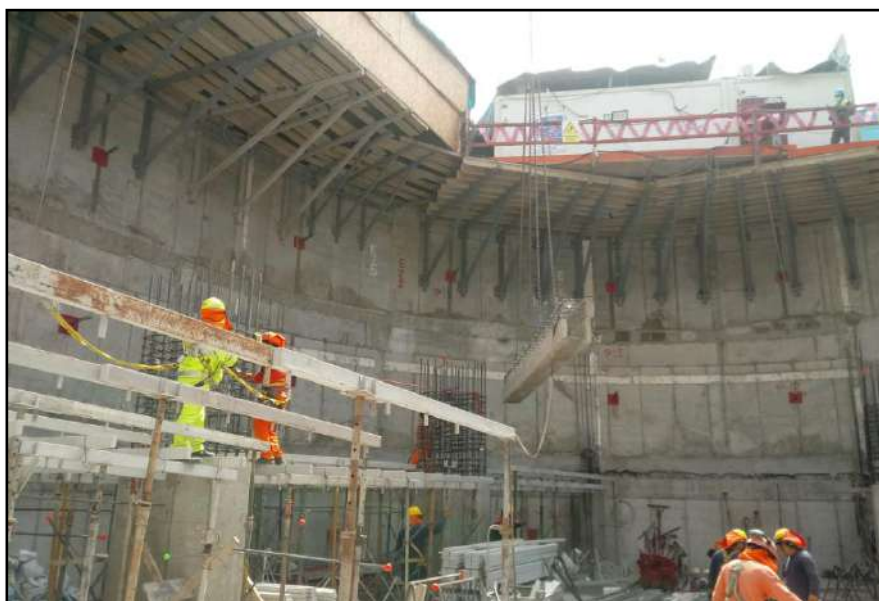
Colocación de previgas
