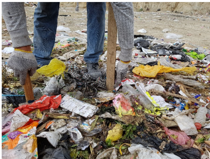
Altura de residuos compactada (0.20m)
