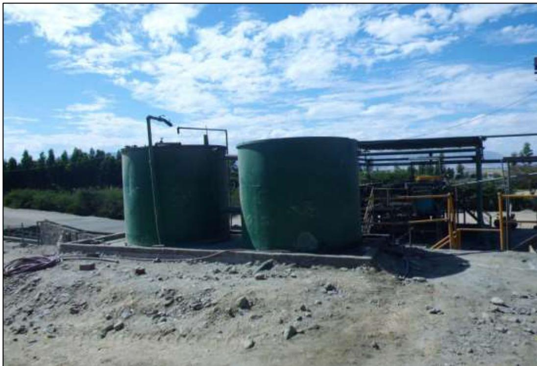
*Nota.* Tanques de abastecimiento de agua para flotación
